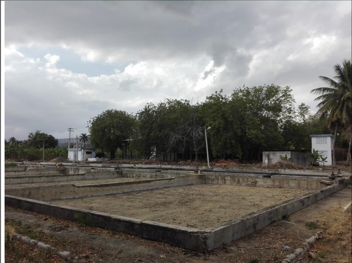
Fotografía del área de secado de lodos
