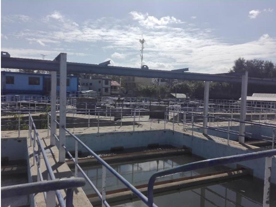
Figura 3-8 : Planta de Tratamiento de Nibaje, floculador-decantador y filtros
