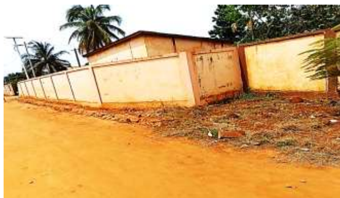
Tranchées creusées mal remblayer en face d'un établissement scolaire ayant causé des accidents aux élèves à Tabligbo
