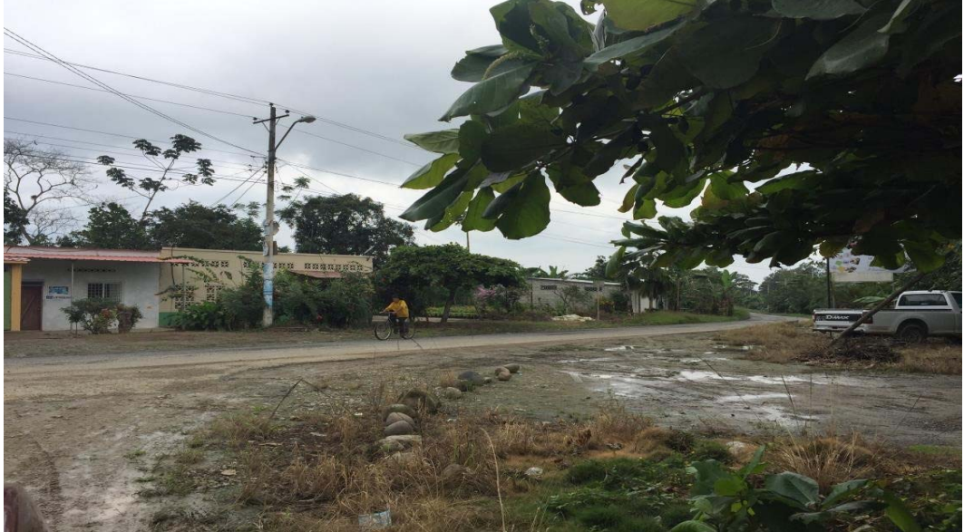
Fotografía 6.4.3-1. Vértice 04 de la L/T S.E. Pasaje – Frontera (CP. Recinto El Progreso)
