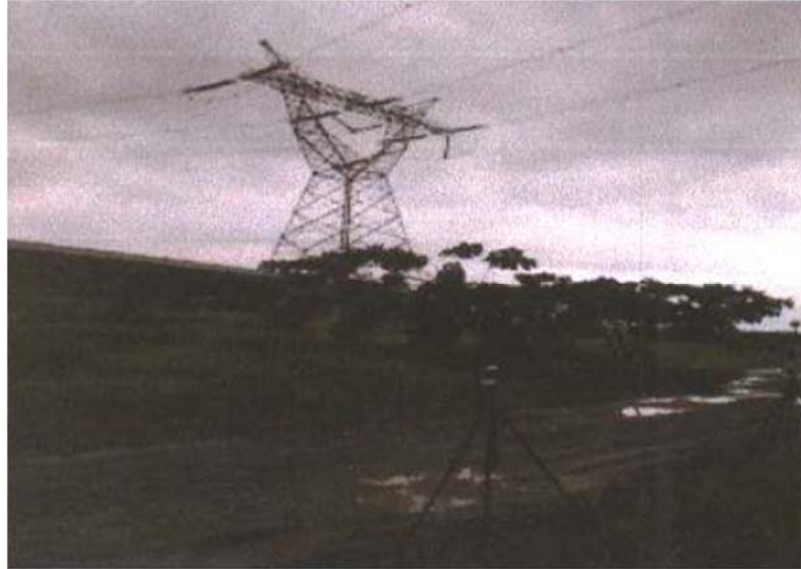
Fotografía 9.1.1-1. Vista del monitoreo de ruido en el Vano 397-398 (referencial)
