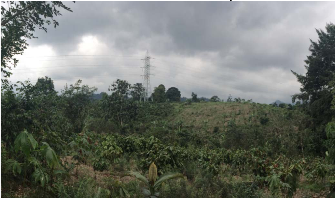
Fotografía 6.1.3.5-3. Tierras con cultivos de cacao - cerca la V30R de la L/T, tramo: S/E Chorrillos - S/E Pasaje
