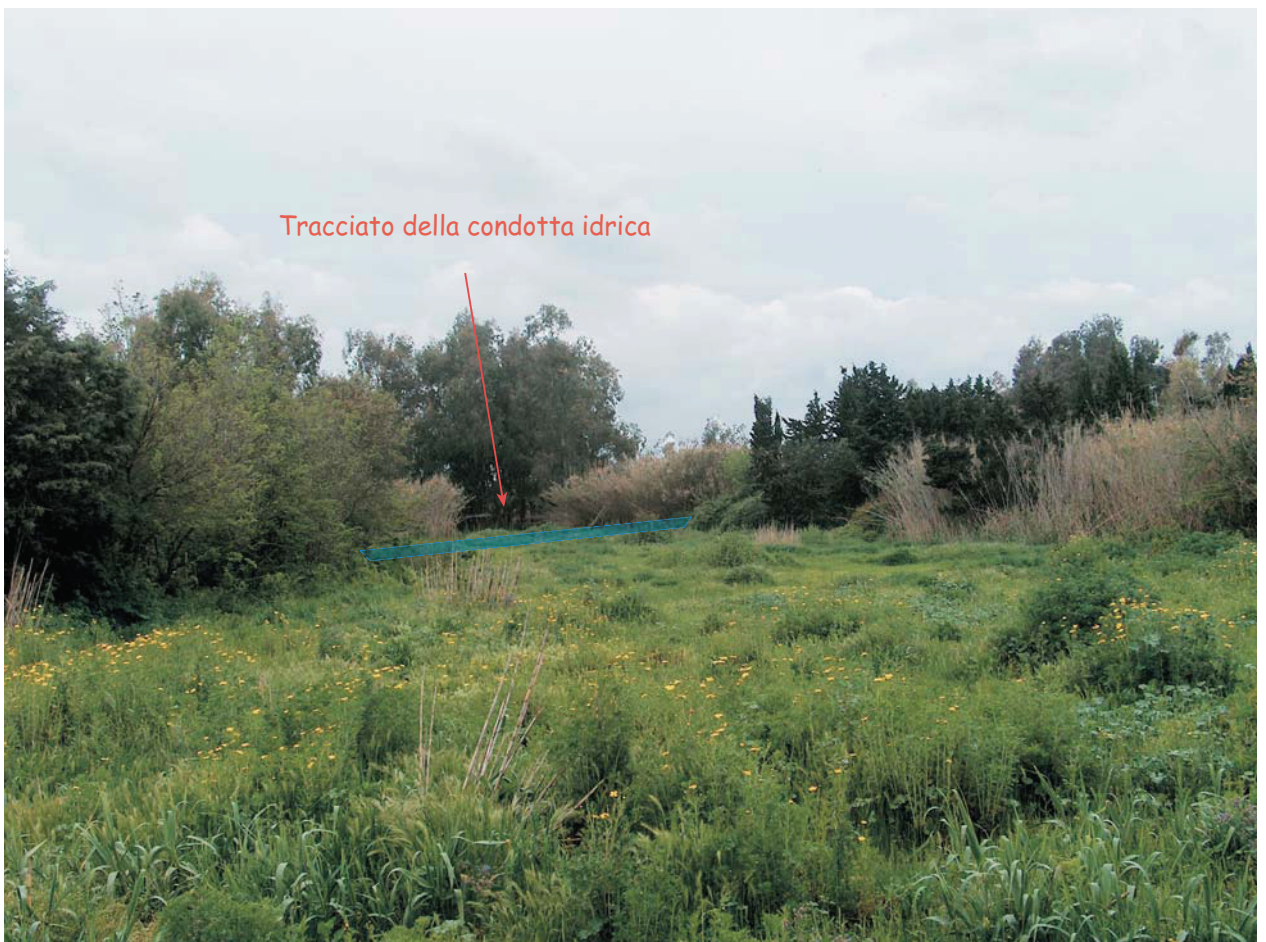
Fotografia 6 - Settore di Riola, la condotta lambisce la fascia alberata oltre la quale scorre il Riu Mare Foghe, passando lungo i confini degli appezzamenti agricoli (veduta verso nord-ovest).
