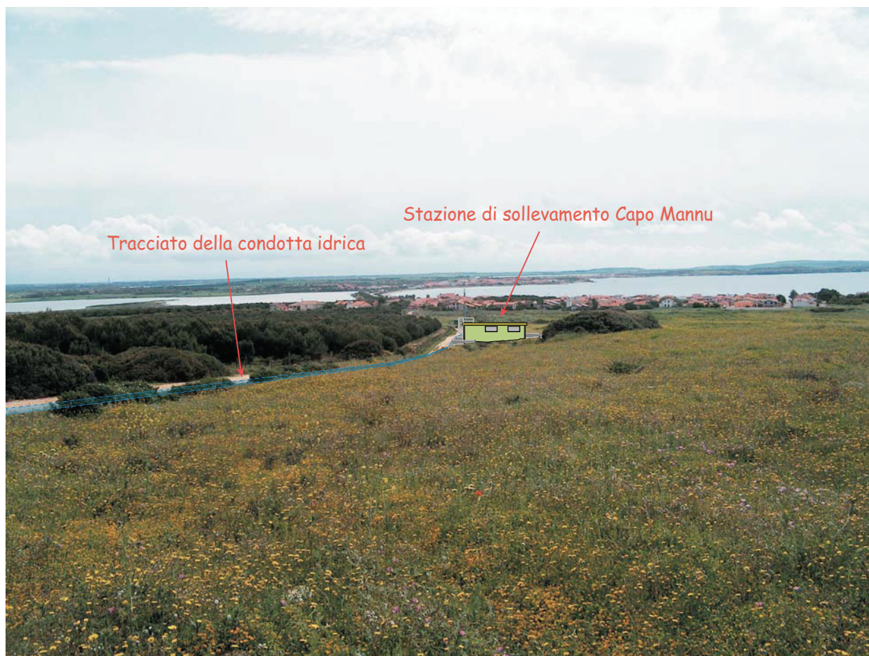
Fotografia 16 - Panoramica dal serbatoio di Capo Mannu verso sud-est, è simulata la localizzazione della stazione di sollevamento in progetto che si integra bene con l'ambiente circostante (Oasi Permanente di Protezione Faunistica).
