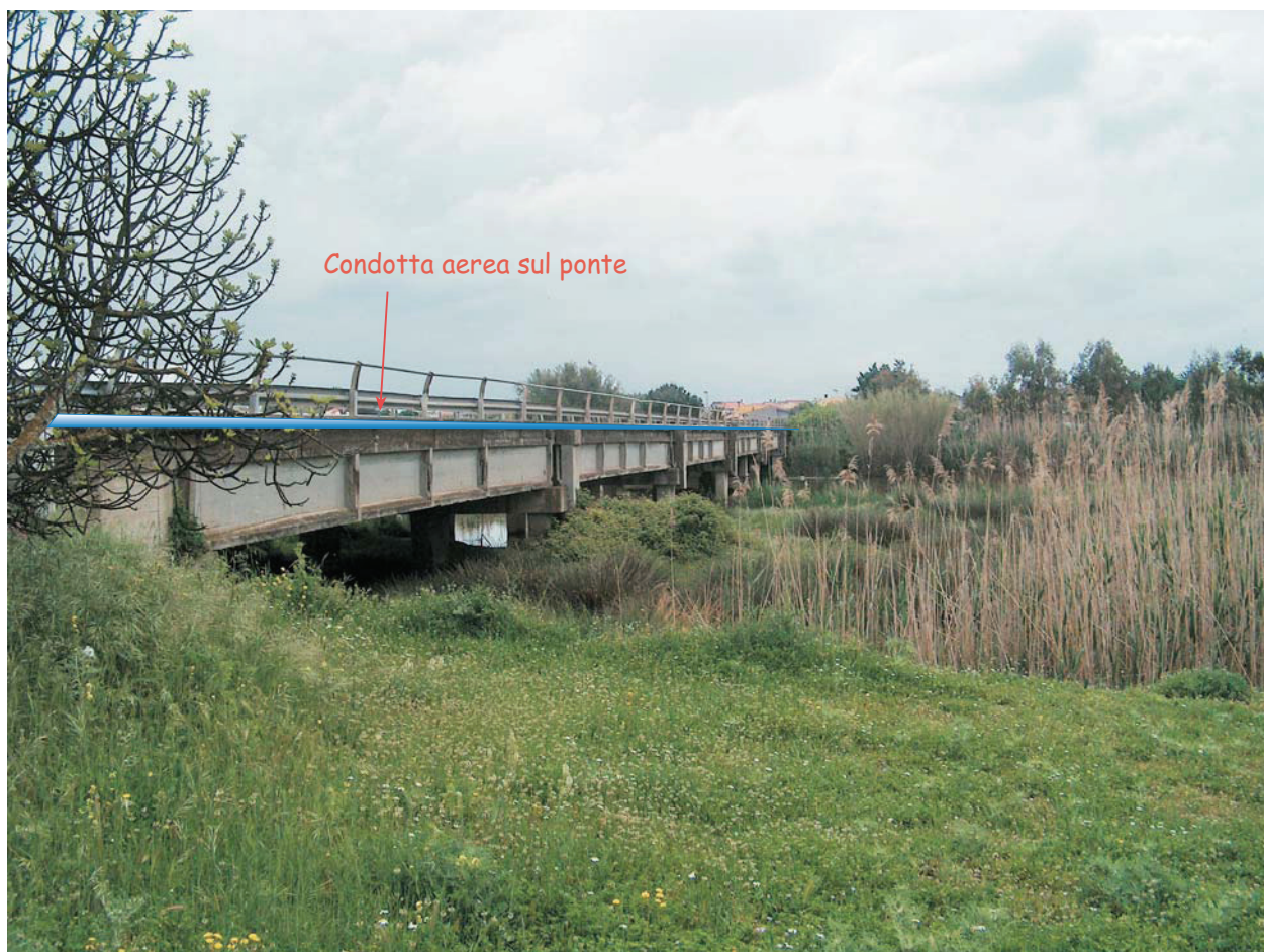
Fotografia 7 - Ponte sul Riu Mare Foghe, veduta verso sud-est, la condotta poggerà sul cordolo in cemento esistente.
