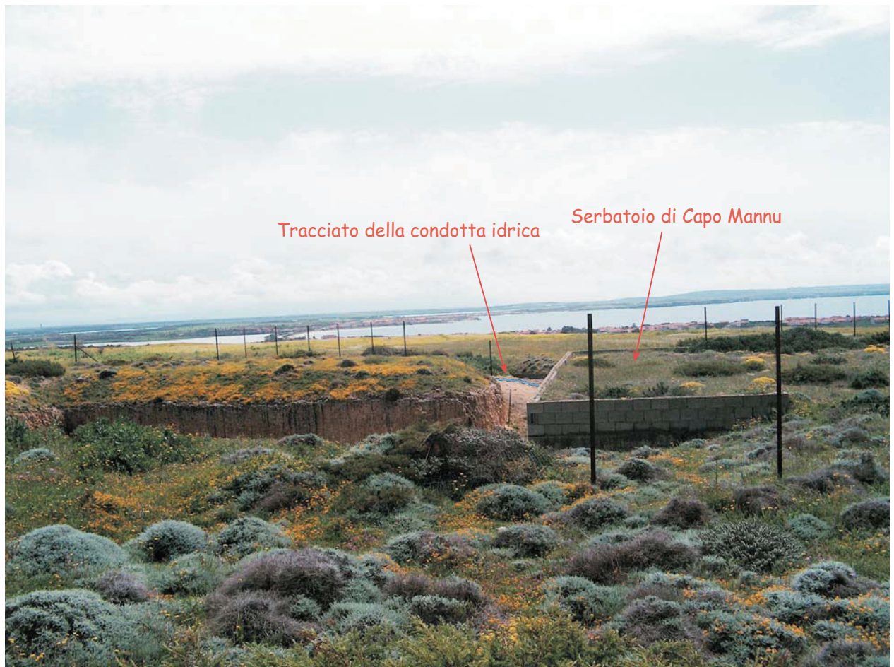
Fotografia 17 - Ultimo tratto di condotta che alimenterà il serbatoio di Capo Mannu, veduta verso sud-est. Il serbatoio esistente è totalmente interrato e gli interventi in progetto permetteranno una migliore integrazione nell'ambiente circostante.
