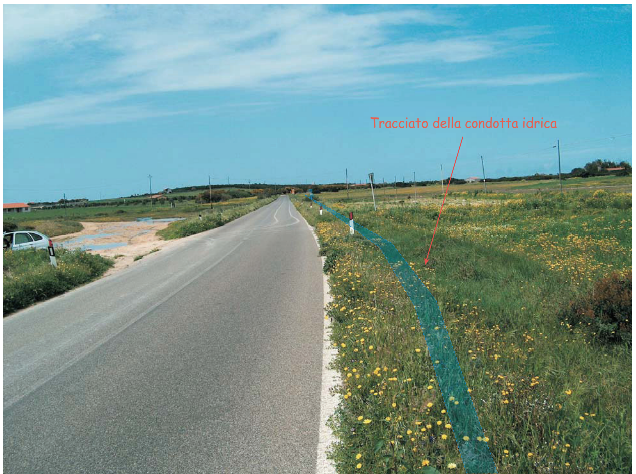
Fotografia 11 - Tratto della strada provinciale n. 10 che lambisce lo stagno di Sale Porcus, attraversando l'area SIC (veduta verso ovest). La condotta passerà sul lato destro della strada, con interferenze assolutamente non significative sull'area umida.
