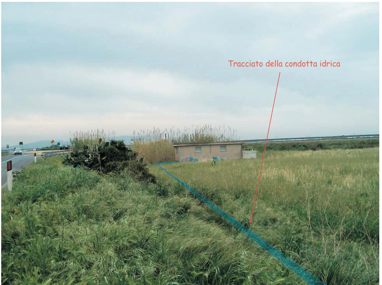
Fotografia 1 - Il partitore Torregrande, punto iniziale dell'acquedotto in progetto (veduta verso sud). Alle sue spalle la strada Oristano-Torregrande.
