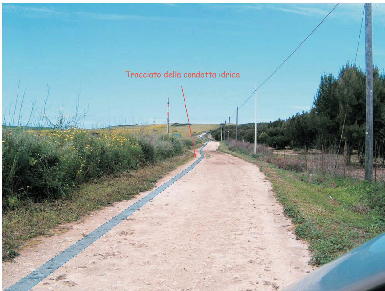
Fotografia 15 - Strada per capo Mannu, la condotta sarà posata lungo il tracciato stradale.
