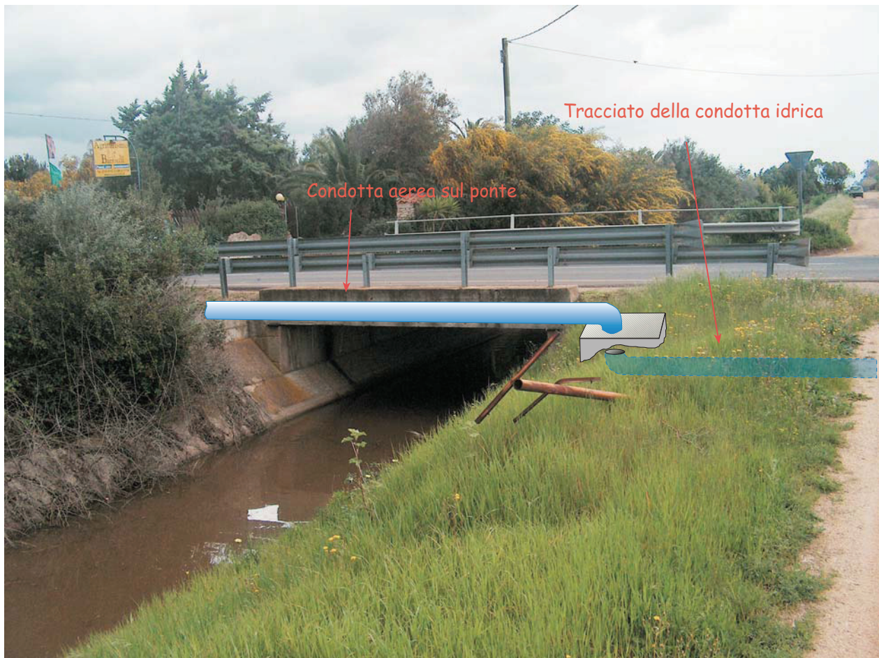
Fotografia 9 - Canale di bonifica presso il Km 117 della SS 292, l'attraversamento sarà del tipo pensile con blocchi di ancoraggio in calcestruzzo. Il colore è volutamente accentuato per motivi grafici, nella realtà si adotteranno colorazioni tali da integrare perfettamente la tubazione con la struttura esistente.
