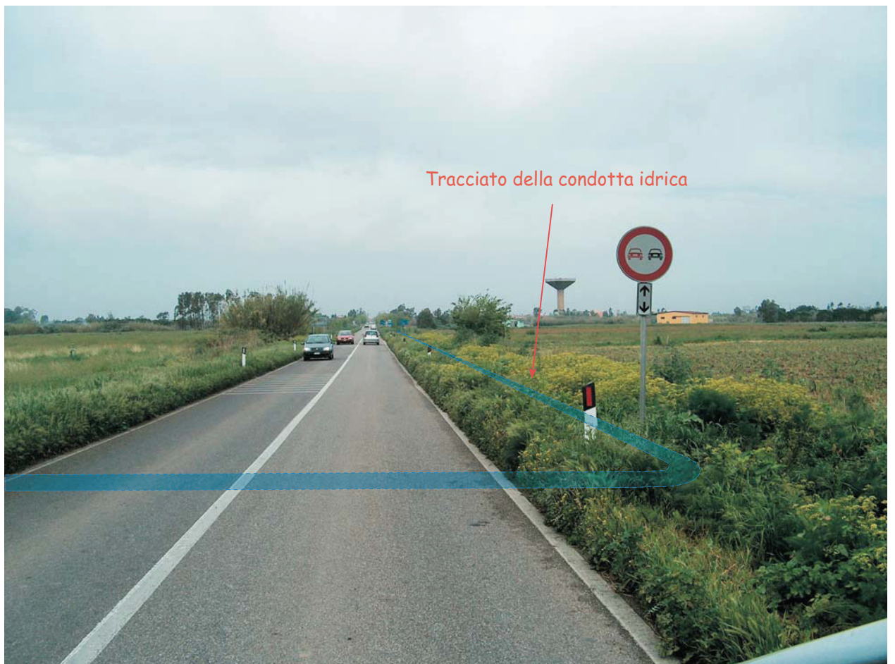
Fotografia 2 - Panoramica del settore a sud di Cabras, la condotta idrica attraversa con spingitubo la strada Oristano-Cabras e prosegue in direzione nord verso Cabras parallelamente alla strada stessa, sino al serbatoio pensile.
