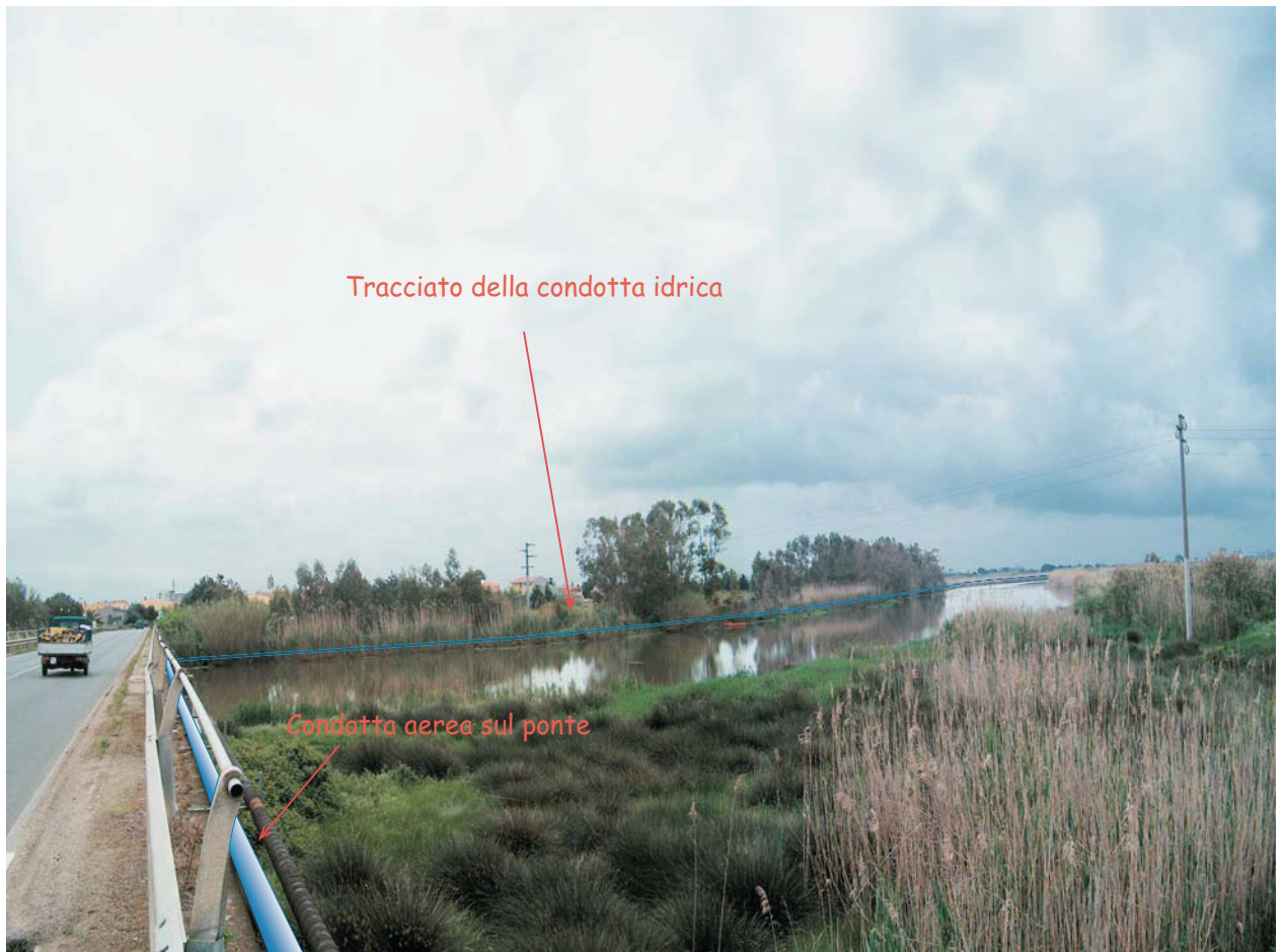
Fotografia 8 - Ponte sul Rio Mare Foghe, presso Riola. La condotta segue la sponda sinistra del fiume, attraverso i canneti (area ZPS ITB034008 "Stagno di Cabras"), quindi attraversa lo stesso fiume passando sul ponte della Strada Statale 292.
