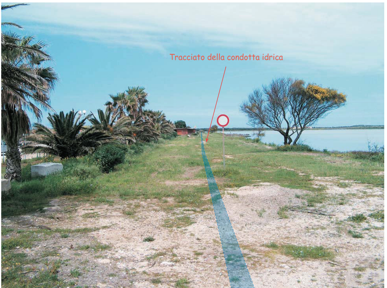
Fotografia 12 - Tratto da Putzu Idu a Porto Mandriola (veduta verso nord-ovest), la condotta sarà posata sul bordo di Sa Salina Manna. L'area rientra nel perimetro del SIC ITB030038 Stagno di Putzu Idu.
