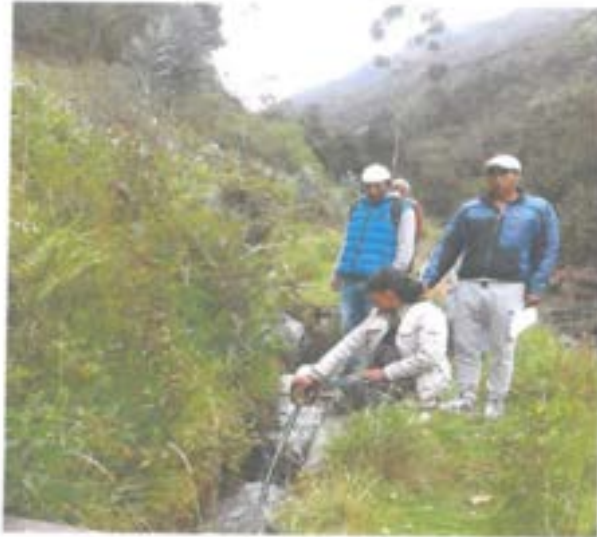
Foto N°03: Zona del proyecto en el cual se observa el canal de conducción de agua.
