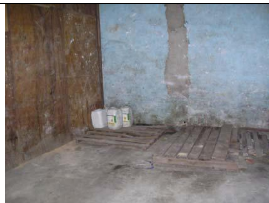
Photo 8 : Vue de l'état des palettes
