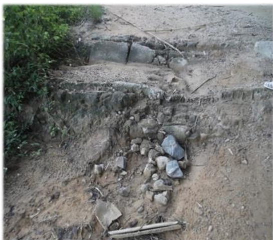
PHOTO 10. OUVRAGE DE DÉCHARGE ENDOMMAGÉ
