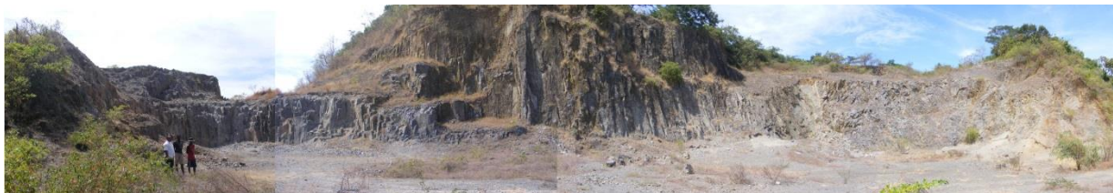
PHOTO 2. FRONT DE TAILLE EXISTANT DE LA CARRIERE DE BEFEFIKA
