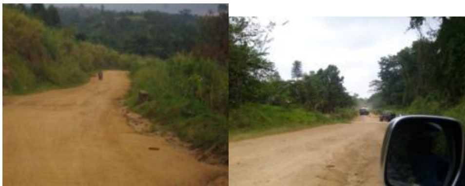
Photos 11 et 12: Aperçu du tracé sur l'axe Beni-Kasindi
