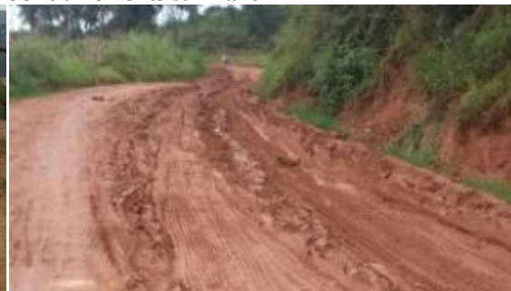
Photo 3 Présence de bourbiers et de ravinelements sur l'axe
