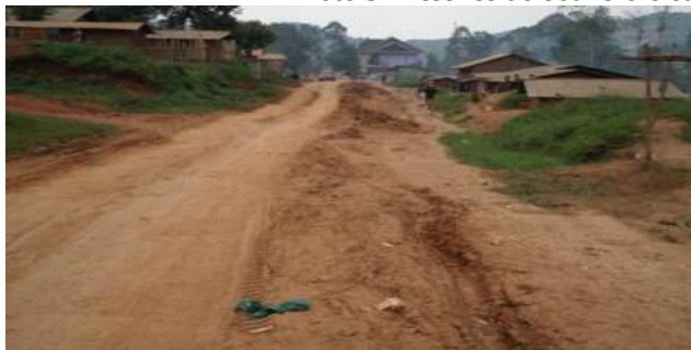
Photo 3 Présence de bourbiers et de ravinelements sur l'axe
