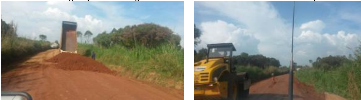
Photo 6 Stockage et présence d'engin matériaux lors de travaux d'entretien sur l'axe par l'OR
