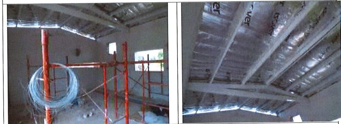
Detalle del estado de construcción de la sala de bombas. A la derecha vista de las cabriadas y de la aislación térmica.
