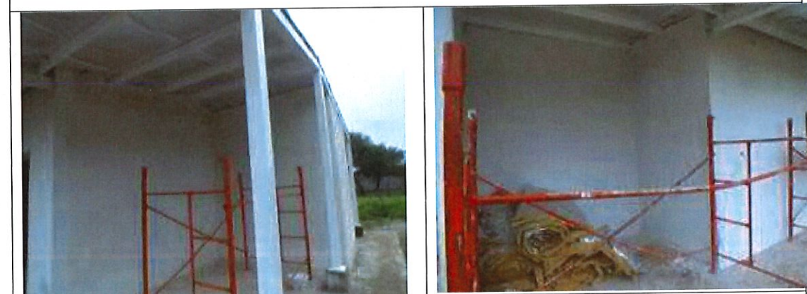
Vista del área posterior de la sala de bombas.
