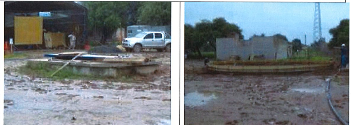
Arriba vista del estado de construcción de la Cámara de ingreso y by-pass. A la derecha se observa el estado de construcción de la cisterna de almacenamiento, realizada con la técnica de tanque abulonado de acero con recubrimiento epoxico.
