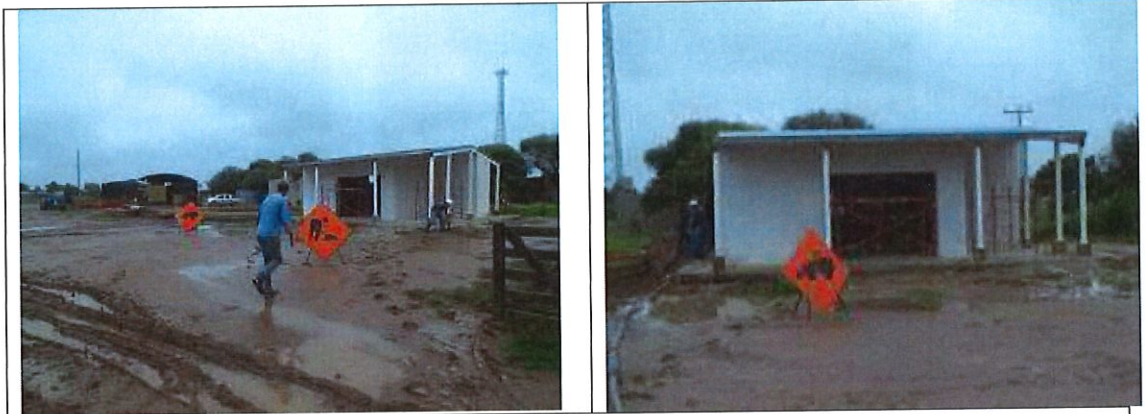
Arriba vista general del estado de construcción de la sala de bombeo en el centro de distribución Miraflores.
