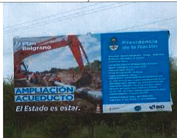
Cartel de Obra del programa
