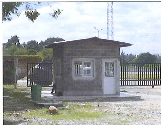
Cabina de seguridad en el acceso.
