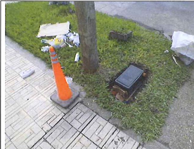
Una vez concluida la instalación el medidor y la vereda afectada es señalizado con un cono de seguridad
