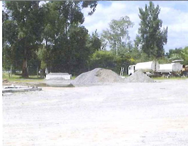
Sector de acopio para materiales de relleno.
