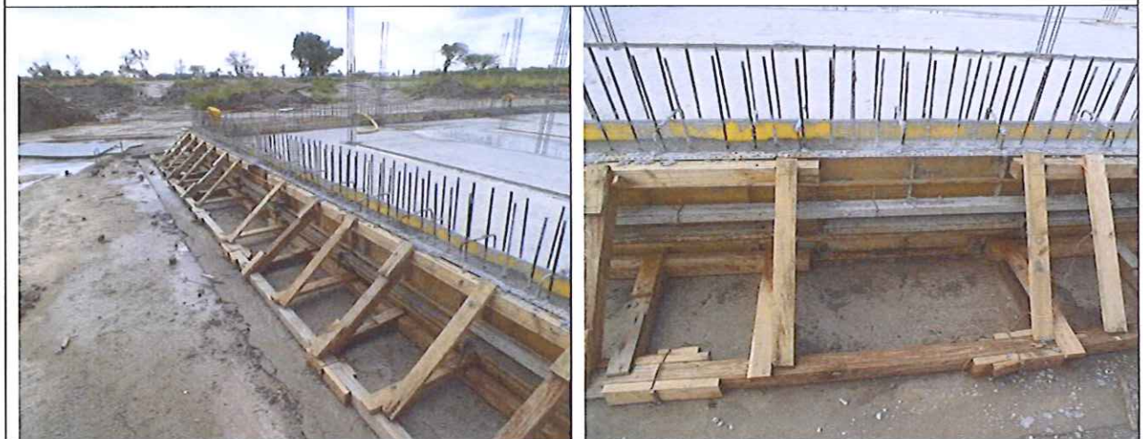
Abajo: Vista de encofrados de madera.
