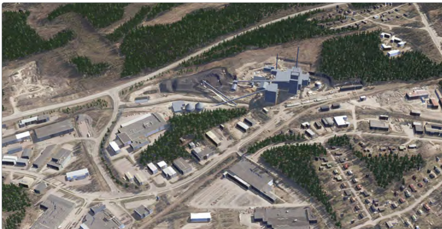
Kuva 41. Maastomallista poimittu voimalaitosalueen nykytilaa kuvaava näkymä ilmaperspektiivistä.
