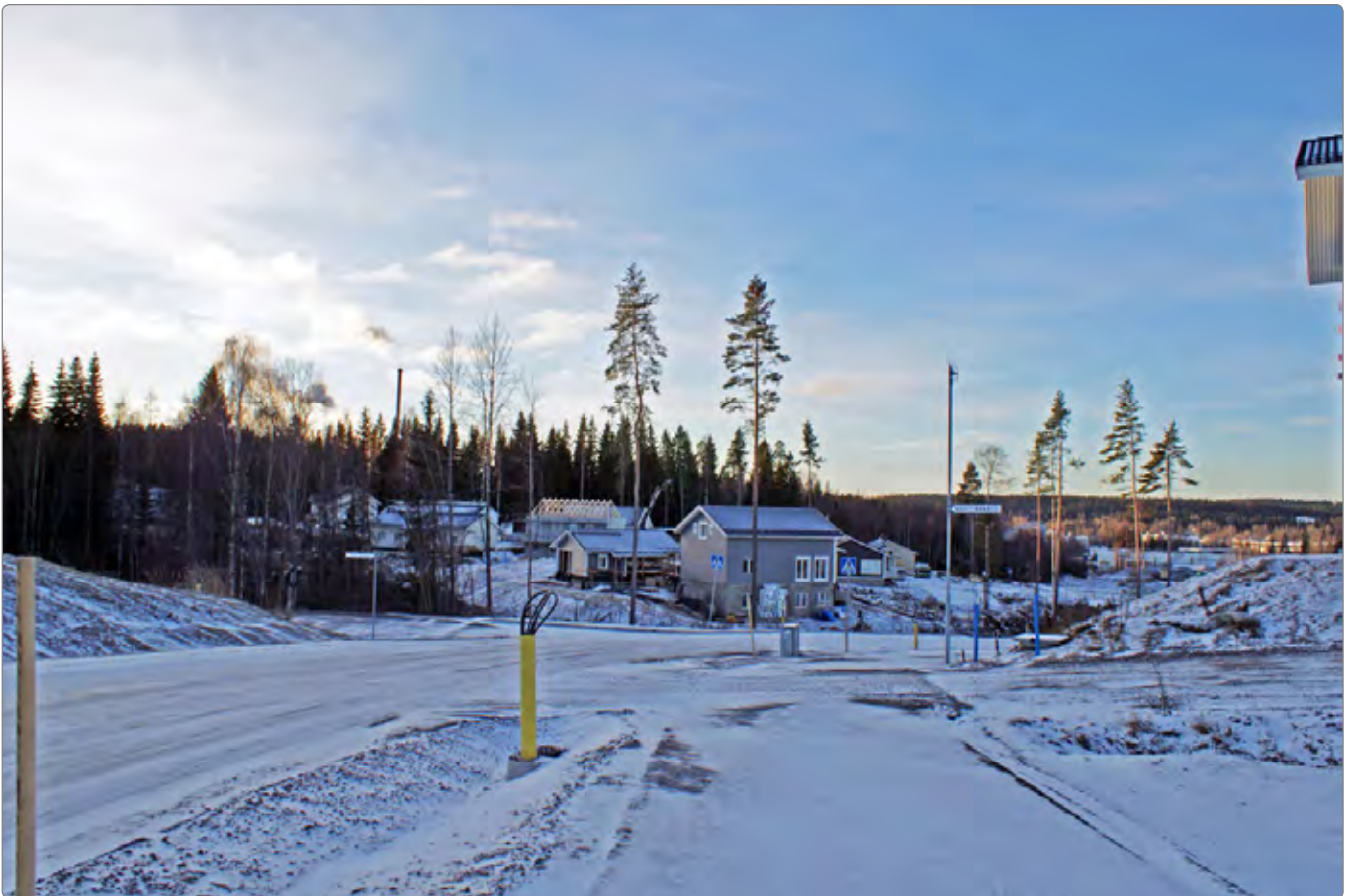
Kuva 47. Näkymä Sipilänkadulta, valtatie 24 pohjoispuolelle rakenteilla olevalta Kytölän pientaloalueelta voimalaitosalueen suuntaan. Kymijärvi I voimalaitoksen piippu näkyy kuvan keskikohdan vasemmalla puolella metsänreunan yläpuolella.
