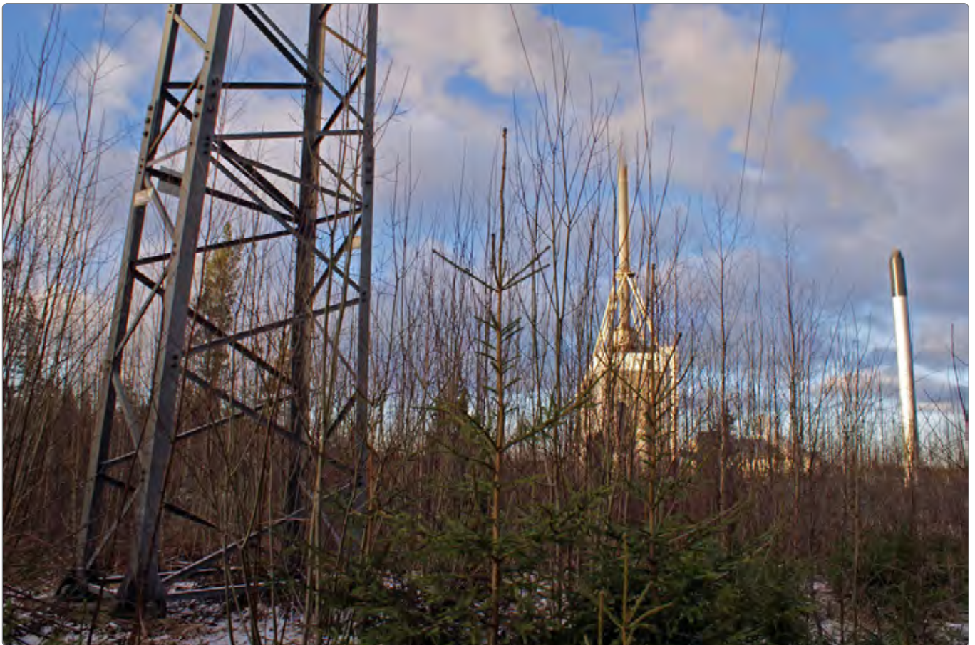
Kuva 45. Näkymä Kumukadun vieriseltä voimajohtoaukealta voimalaitosalueen suuntaan.
