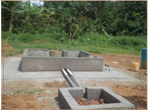
Pompe à pédale bien aménagé à Mayela 1
