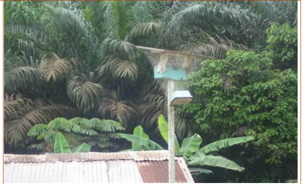
Panneau solaire mal entretenu couvert par des toiles d'araignée
