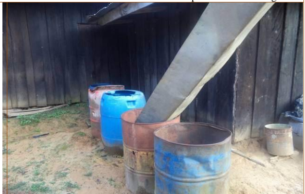
Système de récupération de l'eau de pluie en hivernage
