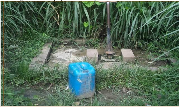
Pompe à pédale mal entretenu au village de Massika 2
