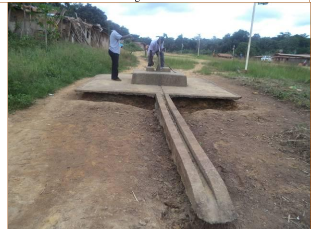
Pompe à pédale mal entretenue (village de Afoumadzo)
