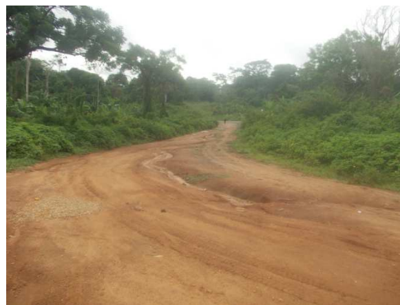
Figure 2 Route au village Ndji à proximité du site du chantier de l'Usine
