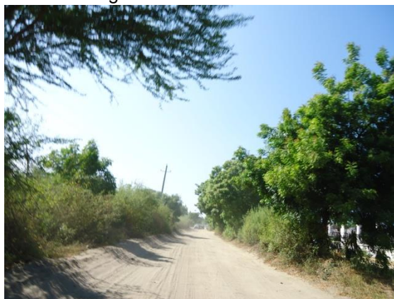
Mchicha Road (Sandali)
