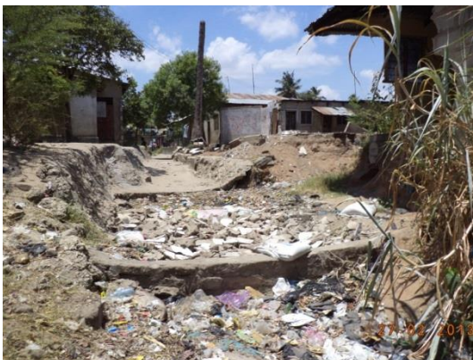
PHOTO 3 KWA SHEGO OPEN DRAIN
