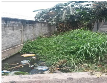
Quartier Djiri à Brazzaville
