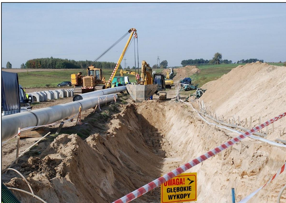
Rycina 17. Organizacja robót podczas budowy gazociągu (Źródło: http://www.gaz-system.pl )
