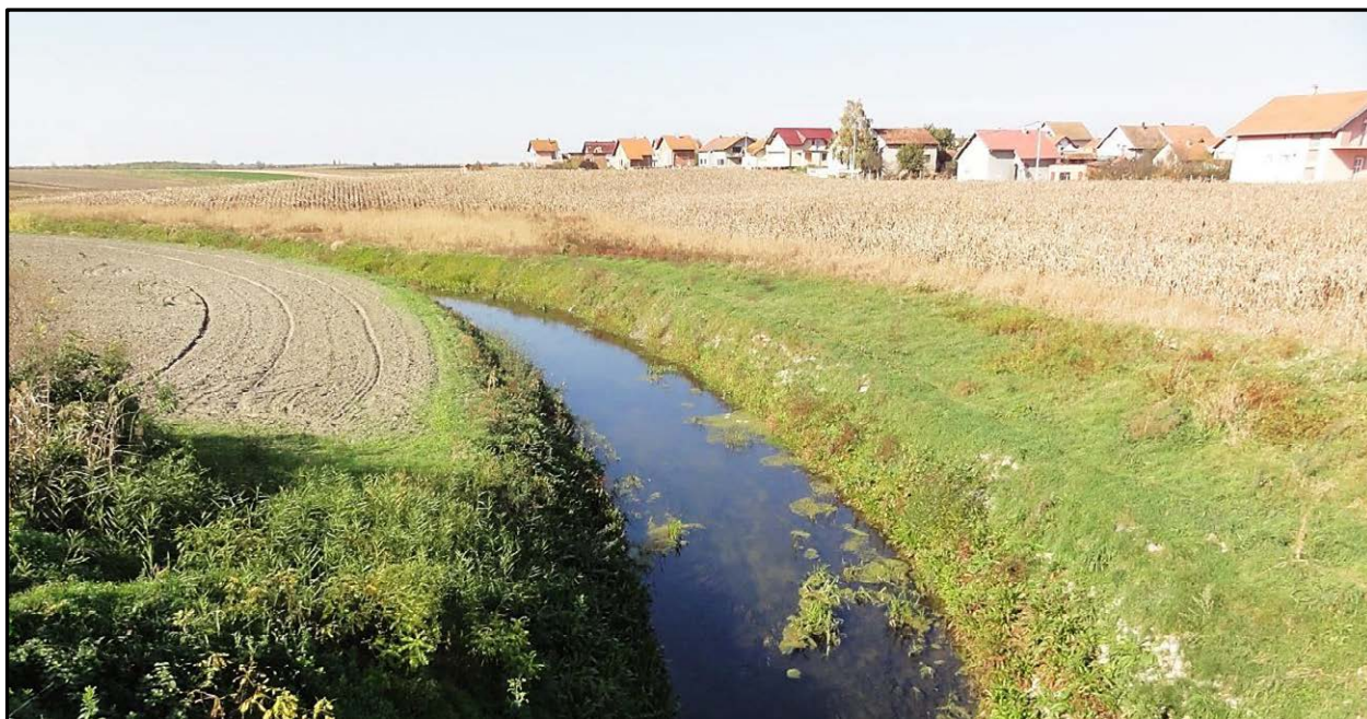
Slika 3.9-2. Pogled na Bobotski kanal sjeverno od predmetne željezničke pruge
