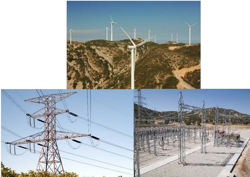
Şekil 1: Rüzgar türbinleri, enerji hatları ve şalt sahası örnek fotoğrafları
