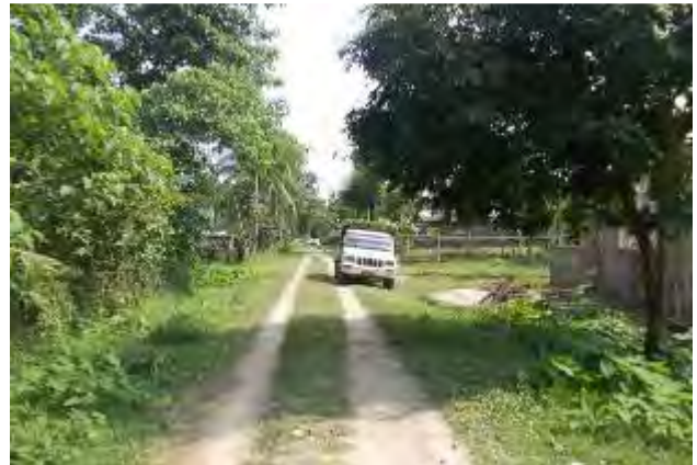
Corridor at 1+000km
