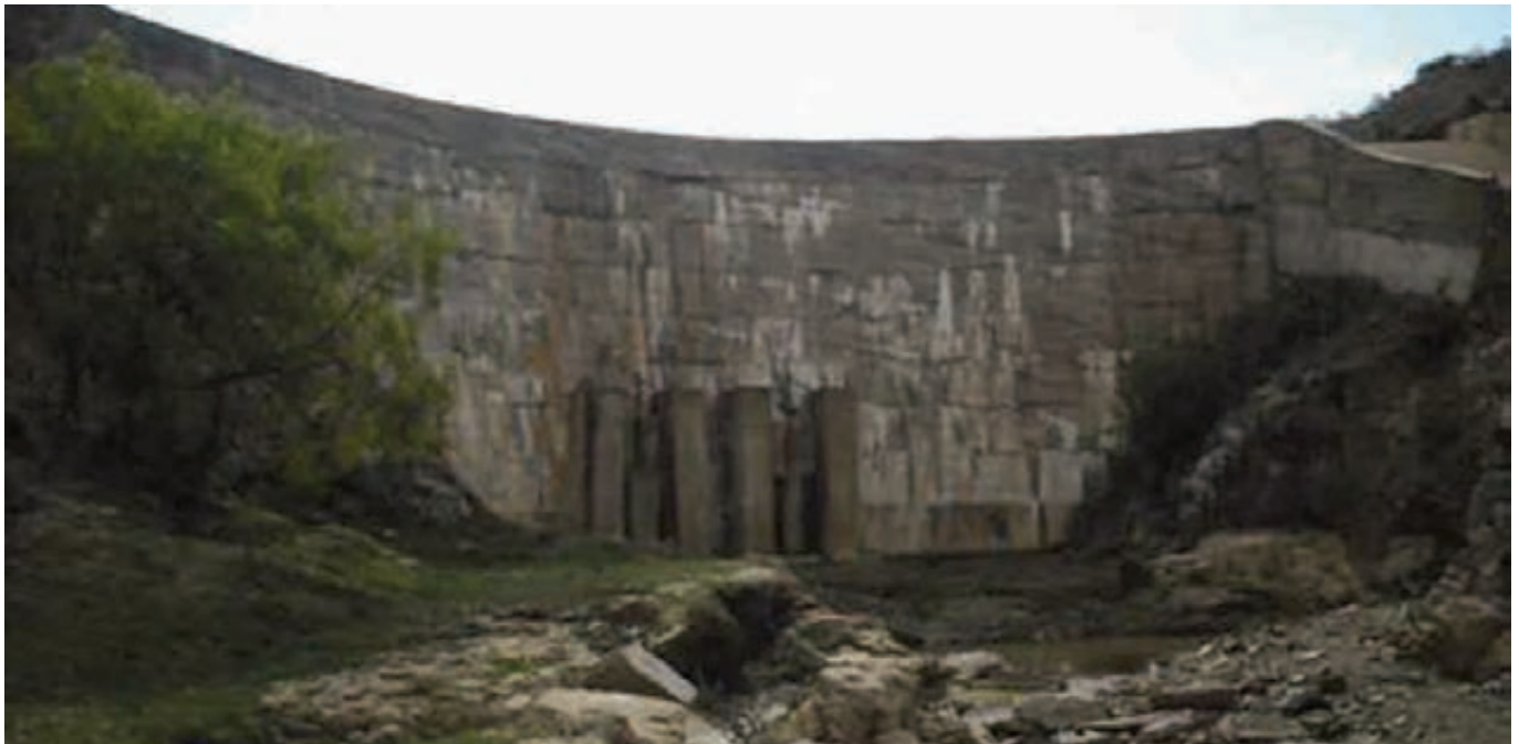
Vista aguas abajo de la presa ,vertedor de excedencias y compuertas de desfogue de fondo
