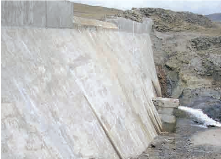
Vista del cuerpo, vertedor y obra de toma de la presa aguas abajo. No se observa el colchón amortiguador.
