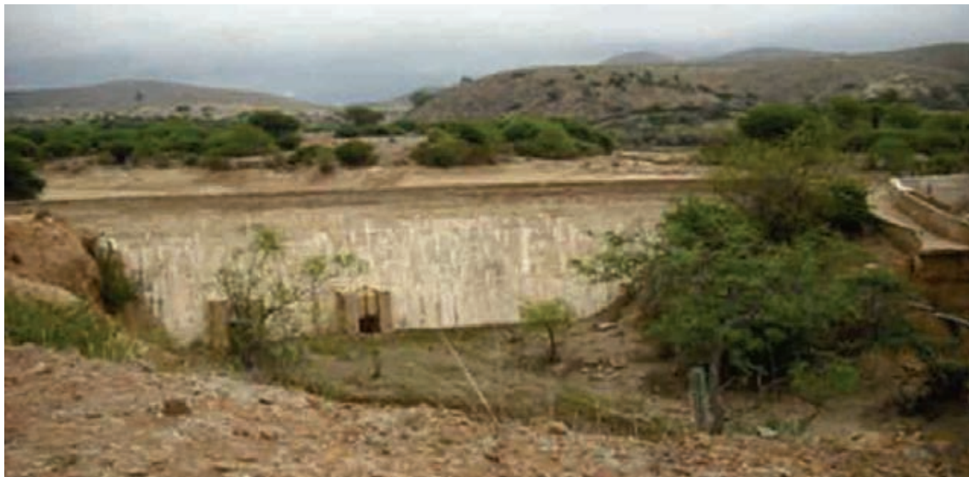
Vista aguas abajo del cuerpo de la presa, vertedor de excedencias y compuertas de desfogue de fondo
