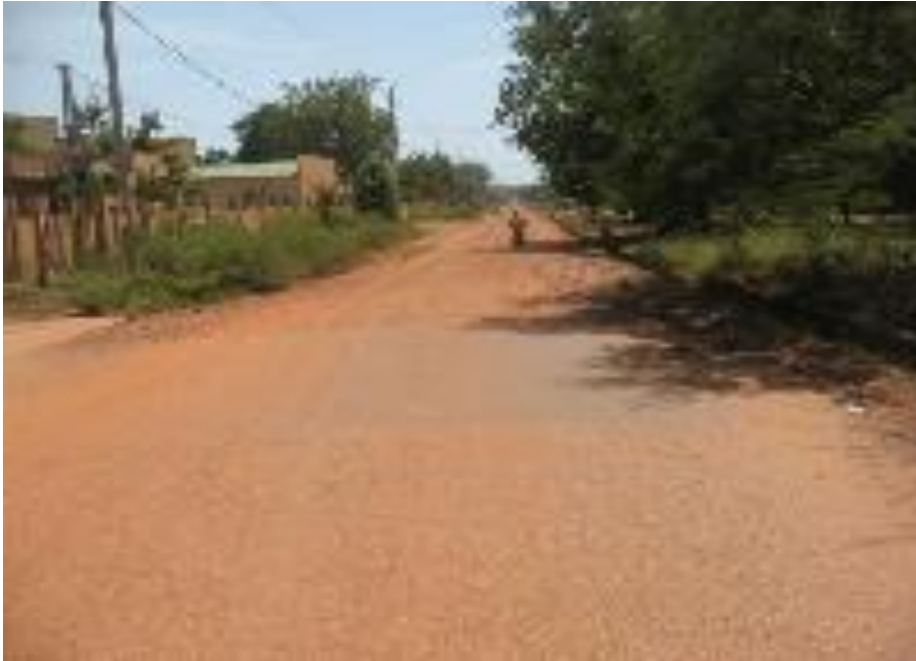
Photo 7 : Vues de la route Manga - Zabré - frontière du Ghana avant aménagement
