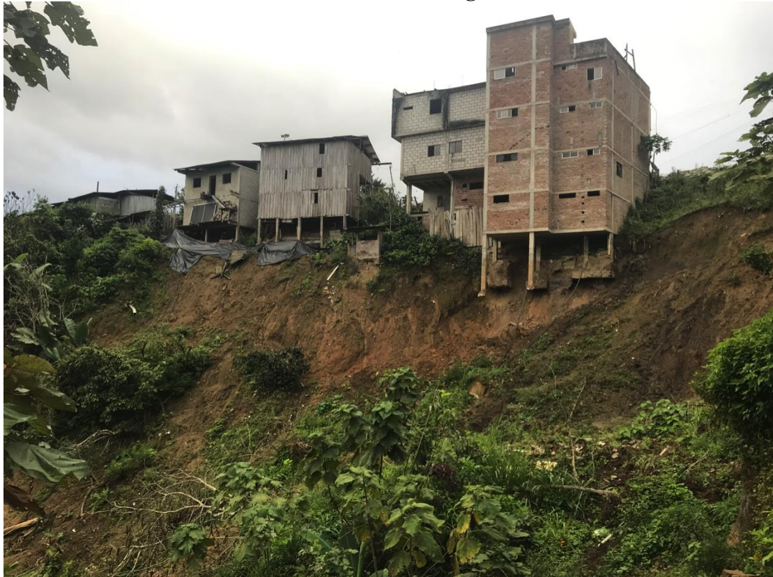
Fotografía 7-7 Derrumbes en El Progreso
