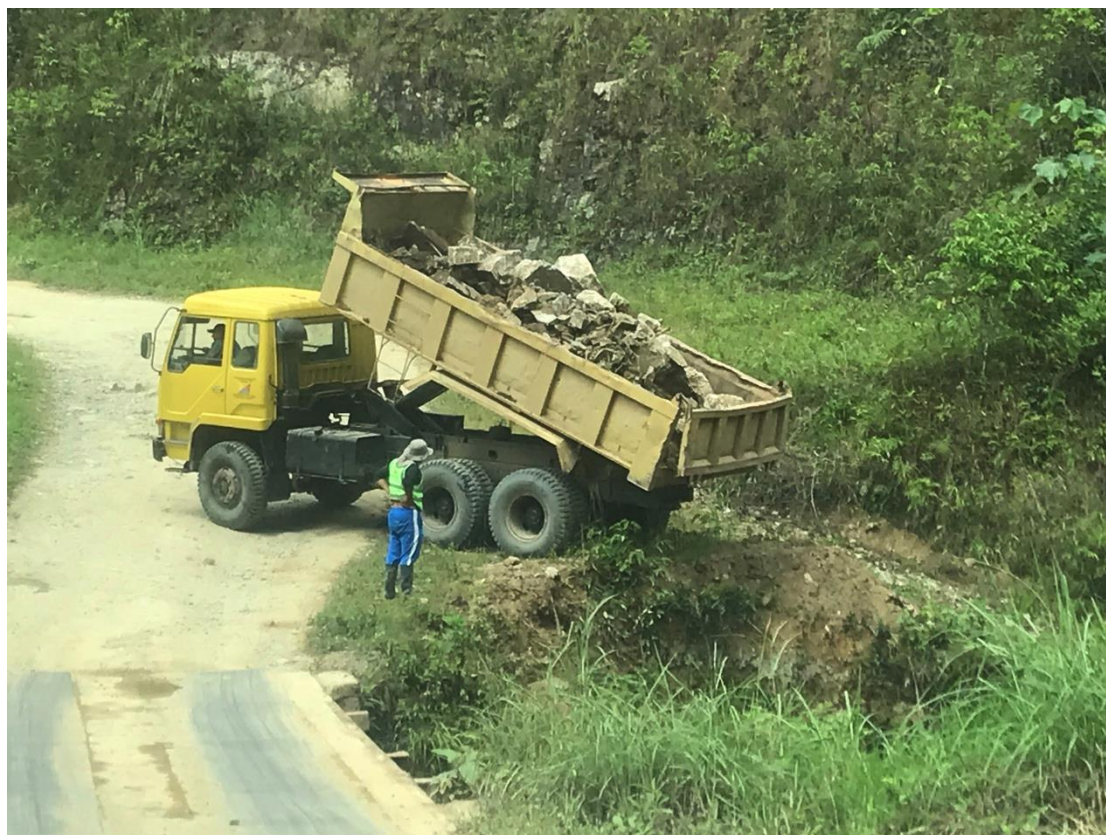
Fotografía 4.4-4 Mantenimiento Inapropiado de la Vía, Descarga de Escombros en el Río. Fotografía Walsh 2019
