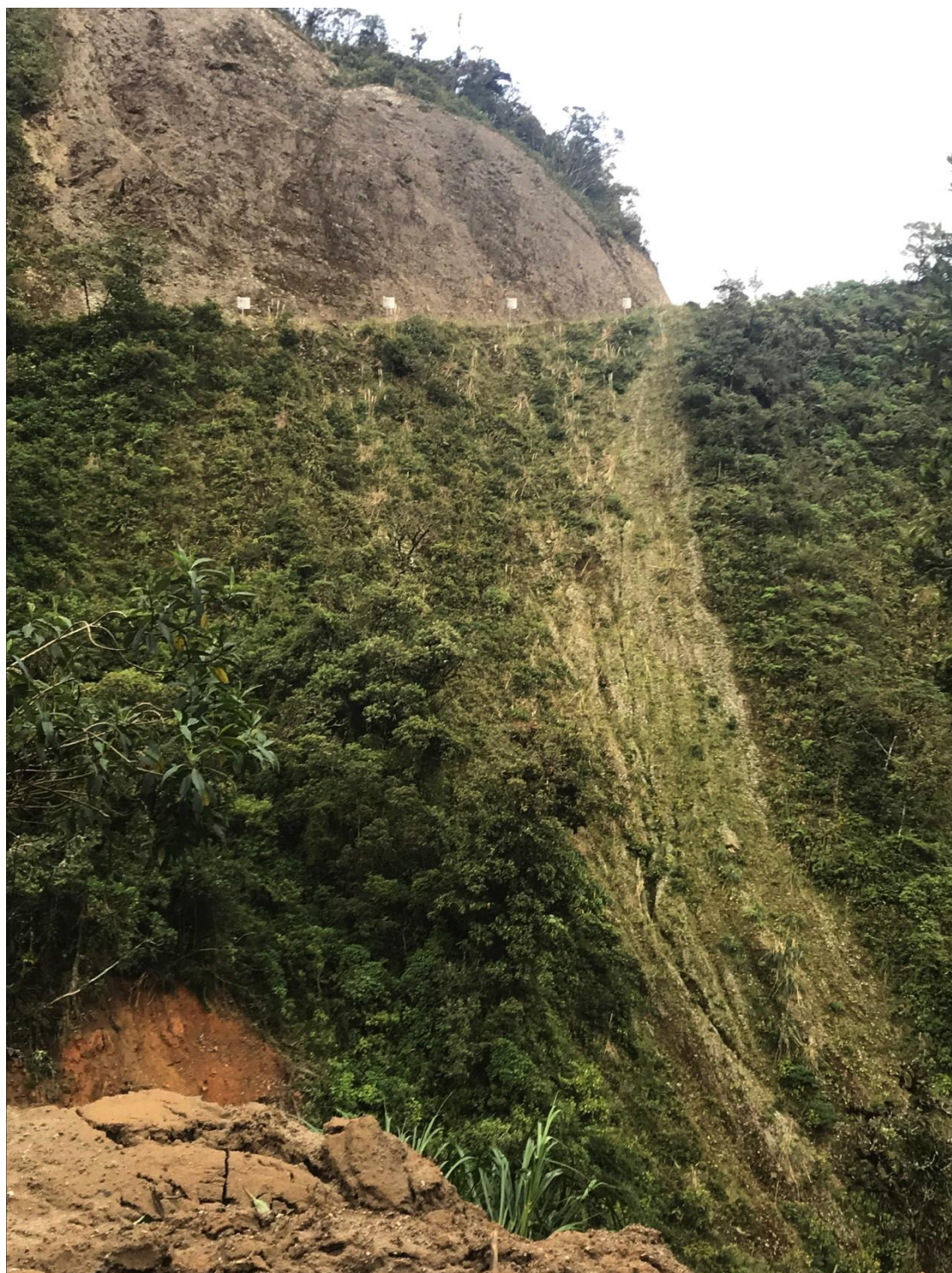
Fotografía 4.3-2 La Carretera en el Parque Nacional Podocarpus, Nótese Huellas de Derrumbe y Recuperación de Vegetación Encima y Debajo de la Superficie de la Carretera. Fotografía Walsh 2019
