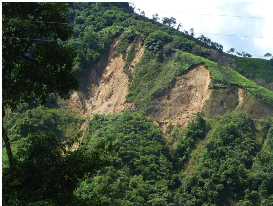
Fotografía 7.3-1 Derrumbes en el Tramo 2 entre Bellavista y El Progreso . Fotografía Walsh 2019
