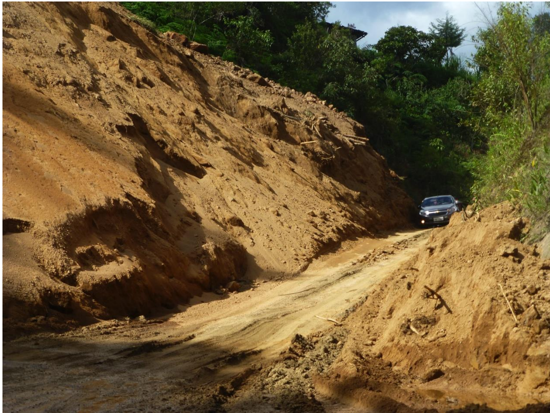
Fotografía 4.4-5 Derrumbe en el Suelo y Roca Madre Lateralizada en un Corte de la Carretera entre Valladolid y Palanda. Fotografía Walsh 2019
