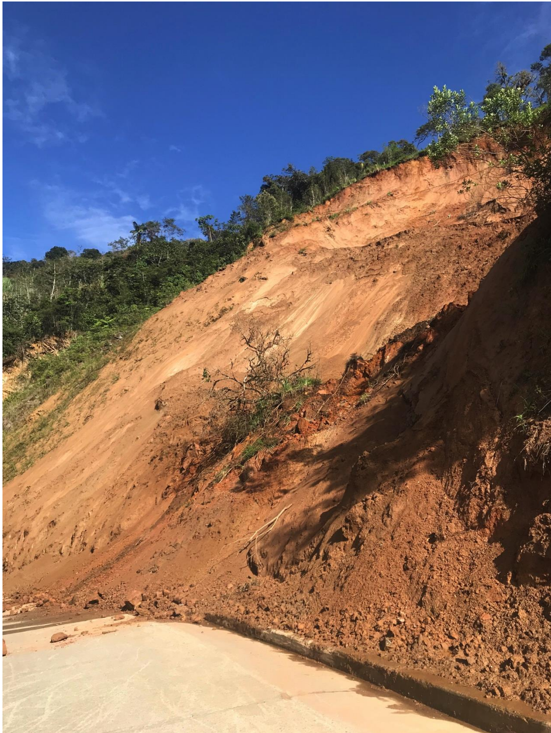
Fotografía 4.4-2 Derrumbe en el Suelo y Roca Madre Lateralizada en un Corte de la Carretera entre Valladolid y Palanda. Fotografía Walsh 2019
