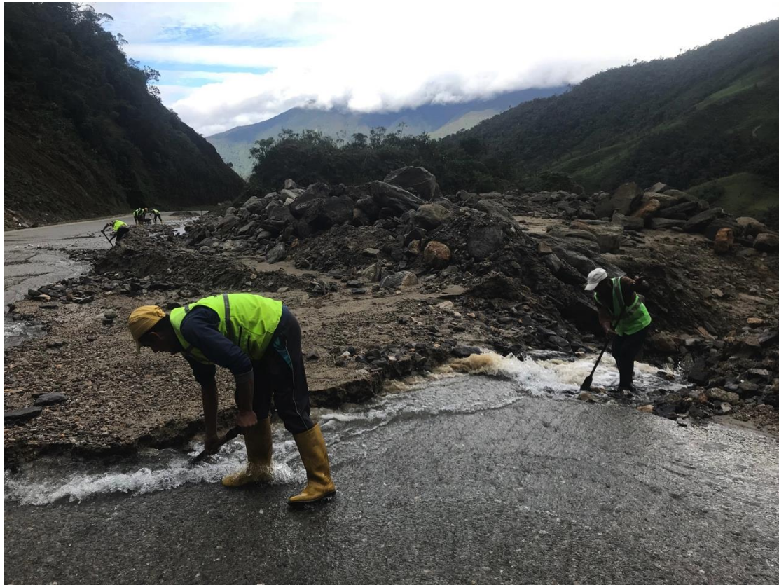
Fotografía 4.3-3 Trabajadores Limpiando un Flujo de Escombros (Aluvión) de la Superficie de la Carretera. Fotografía Walsh 2019
