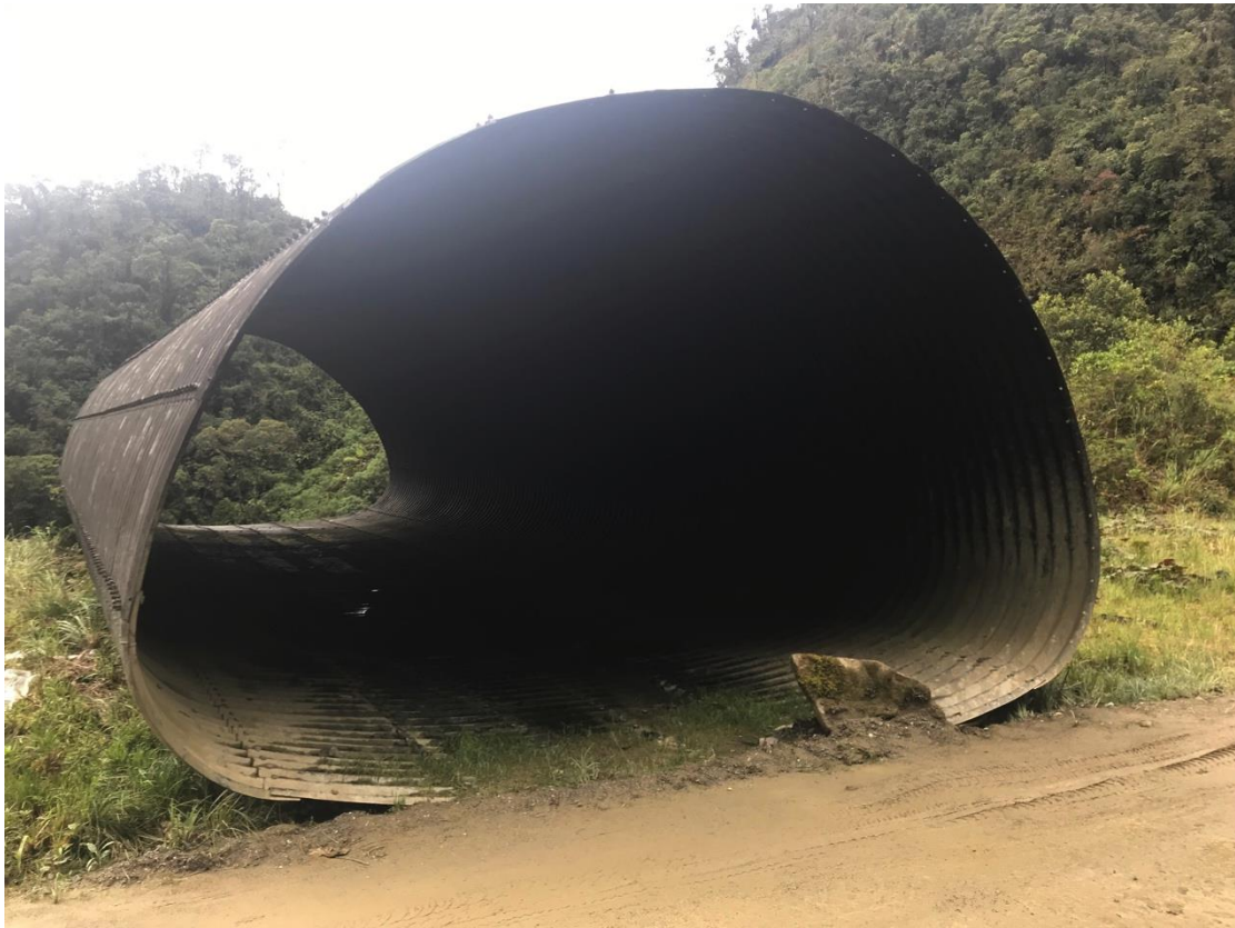
Fotografía 4.3-6 Alcantarilla de Gran Diámetro para Cruces de Arroyos, Montada y Lista Para su Instalación en la Carretera. Fotografía Walsh 2019
