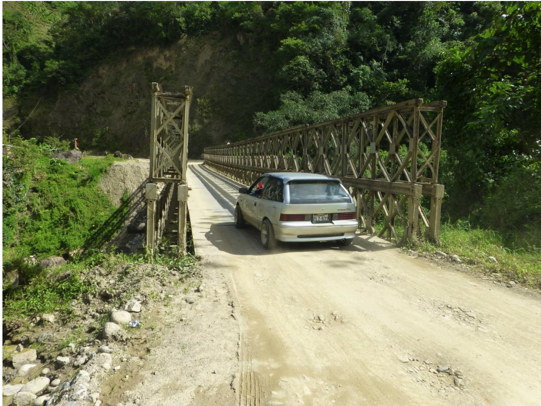
Fotografía 4.4-3 Puente Baily Sobre el Río Valladolid. Fotografía Walsh 2019
