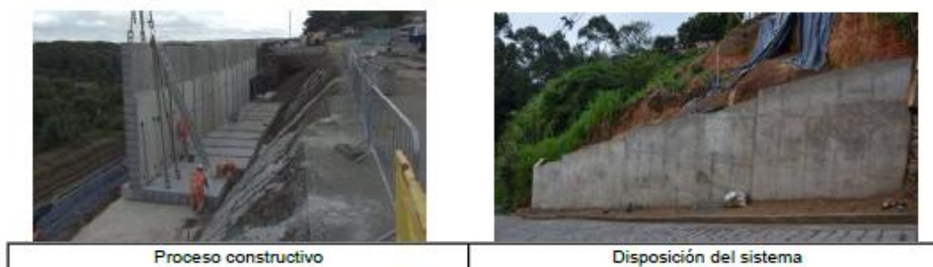
Figura 4-20. Muro de contención gravitacional
