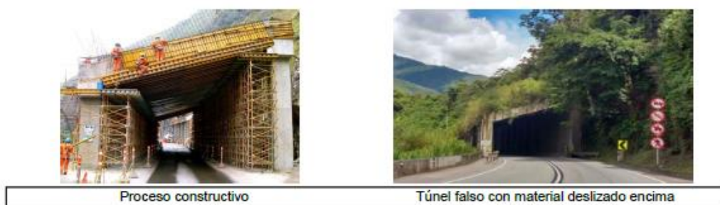
Figura 4-18. Túnel falso – Viaducto
