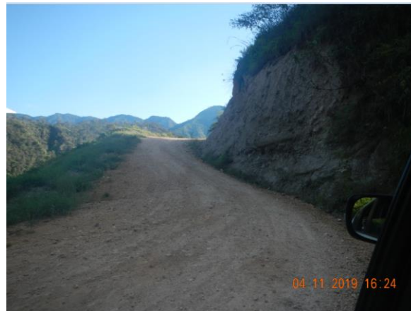
Cortes en estratos de areniscas con intercalaciones de conglomerados sobre la vía actual en la ladera norte del río Canachis en la vía actual
