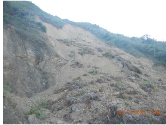
Cuerpo deslizando en la vía actual que afectará el proyecto entre el K45 y K46
