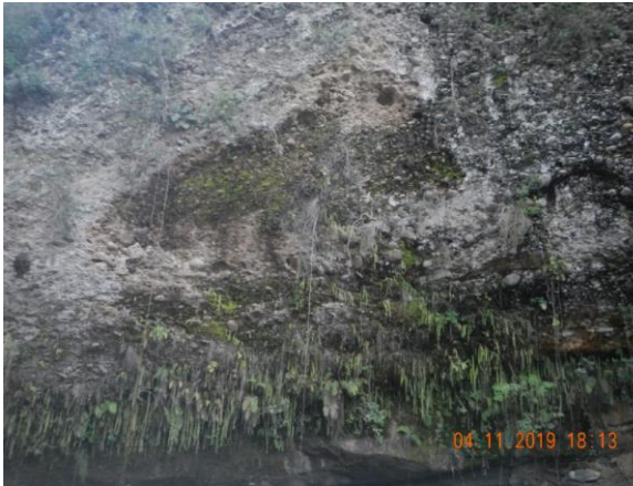
Afloramiento de conglomerados formando taludes verticales entre las localidades de El Chorro y Pucabamba en la vía actual
