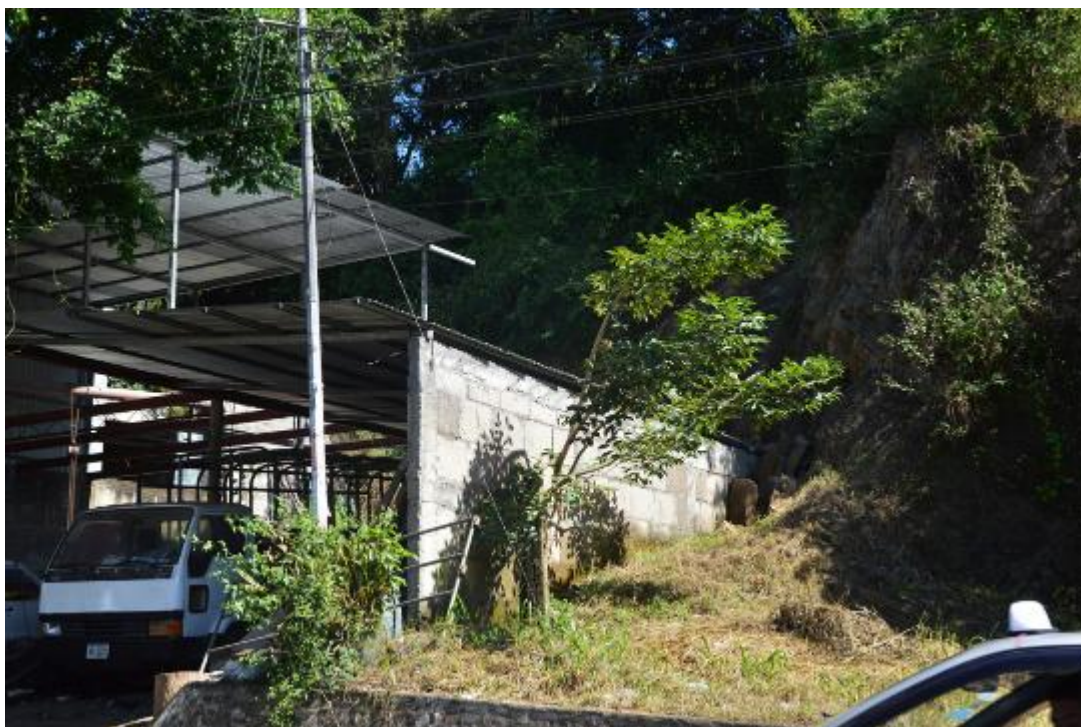
Imagen 5. Vivienda construida en área de socavamiento. Ciudad Boaco, salida hacia Managua
