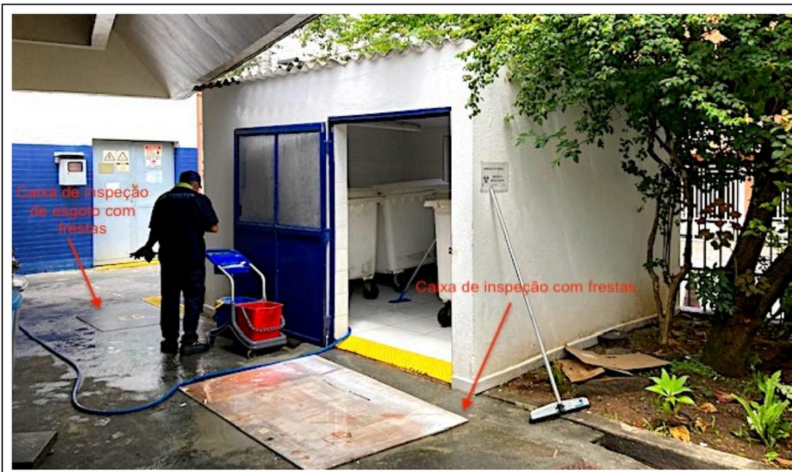
**Figura Nº 20:** Hospital Municipal Dr. Alexandre Zaio. Depósito de lixo infectante. Piso e drenagem inadequados e caixas de inspeção instaladas na frente do depósito dificultando a limpeza.
