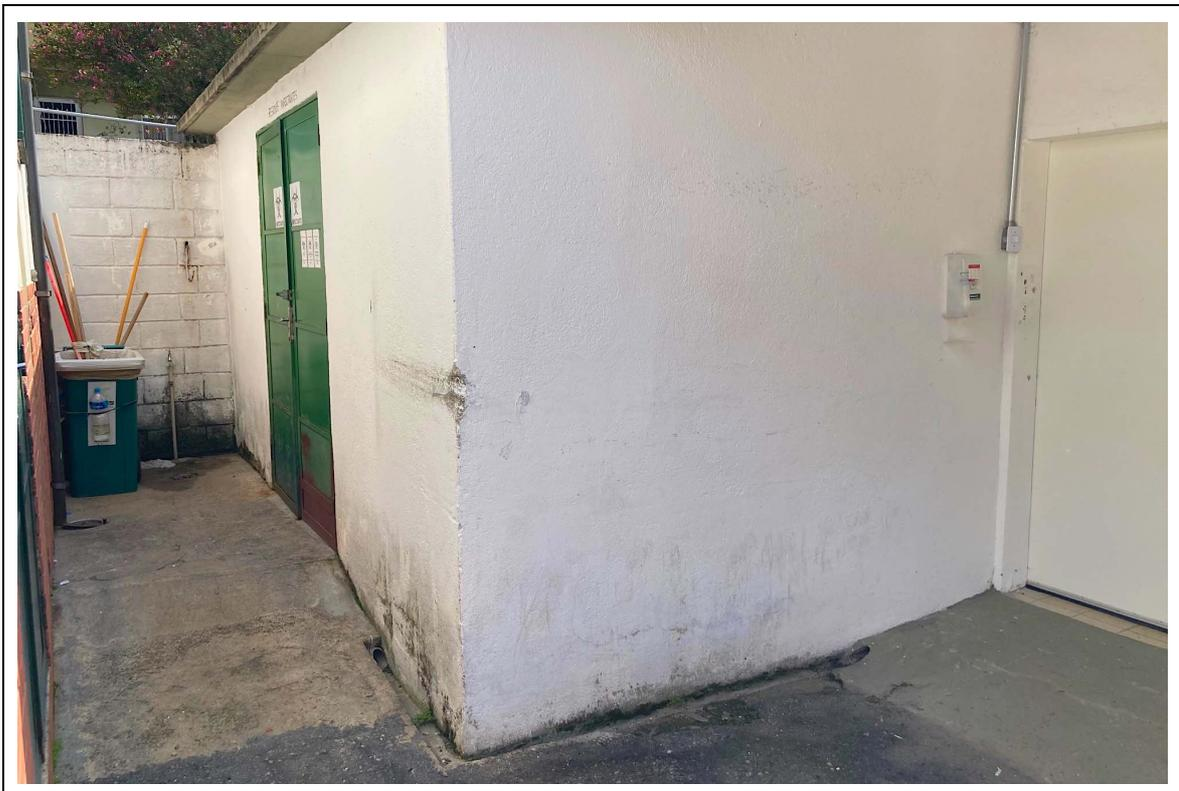
**Figura Nº 40:** Hospital Municipal e Maternidade Mario Degni. Depósito de lixo infectante com acesso, piso e drenagem inadequados.
