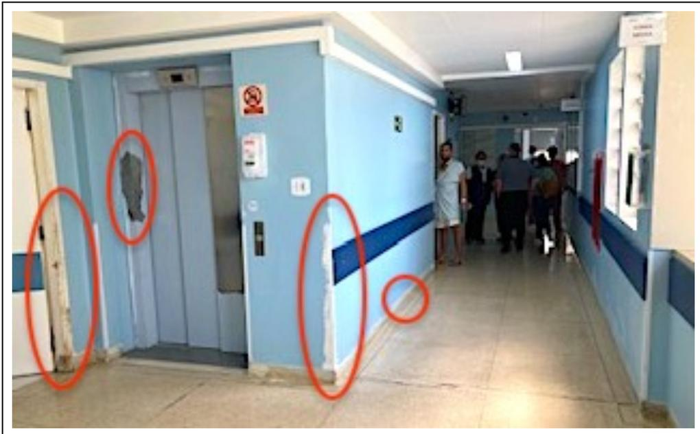
**Figura Nº 6:** Corredor interno do Hospital e Maternidade Dr. Ignácio Proença de Golvêa. Piso, bate maca e teto inadequados, manutenção deficiente e elevador que não permite o transporte de pacientes em cama hospitalar.
