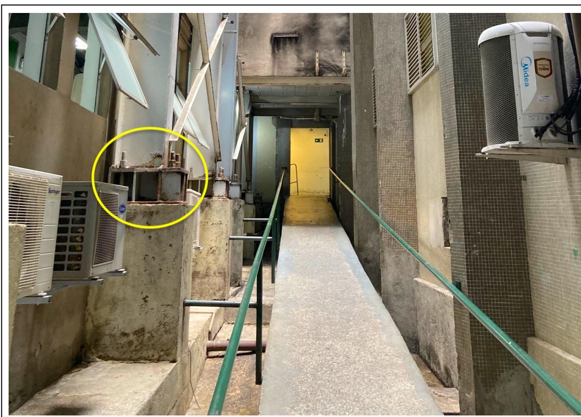
**Figura Nº 30:** Hospital Tide Setúbal. Acesso interno de funcionários ao interior do Hospital. No círculo amarelo, ferrugem em estado avançado da estrutura metálica, denotando falta de manutenção.
