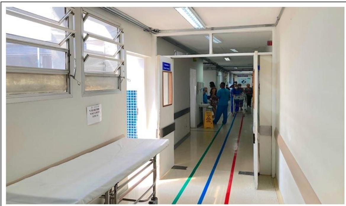
**Figura Nº 43:** Hospital Municipal e Maternidade Mario Degni. Corredor interno em desacordo com as normas e padrões de instalações de serviços de saúde e segurança, sobretudo com relação ao piso, teto, instalação elétrica, identificação de rotas de fuga e implantação de Projeto de Segurança Contra Incêndio e Pânico – PSCIP.
