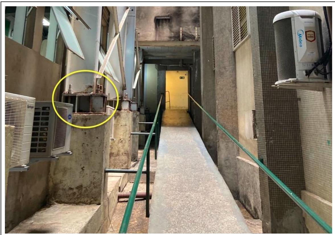
**Figura Nº 32:** Hospital Tide Setúbal. Acesso interno de funcionários ao interior do Hospital. No círculo amarelo, ferrugem em estado avançado da estrutura metálica, denotando falta de manutenção.
