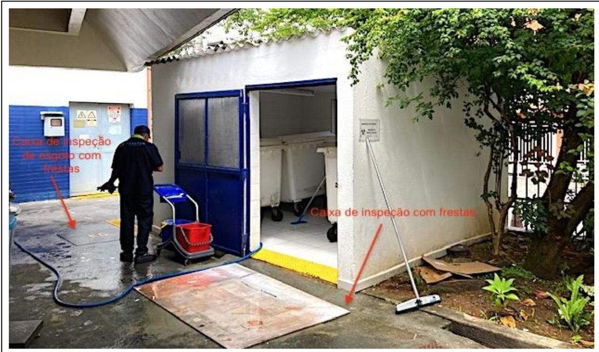
**Figura Nº 24:** Hospital Municipal Dr. Alexandre Zaio. Depósito de lixo infectante. Piso e drenagem inadequados e caixas de inspeção instaladas na frente do depósito dificultando a limpeza.
