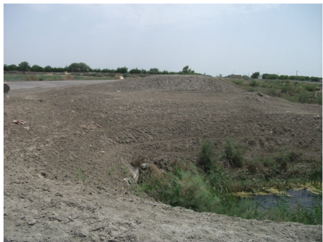
Drainage channel (km 234)
