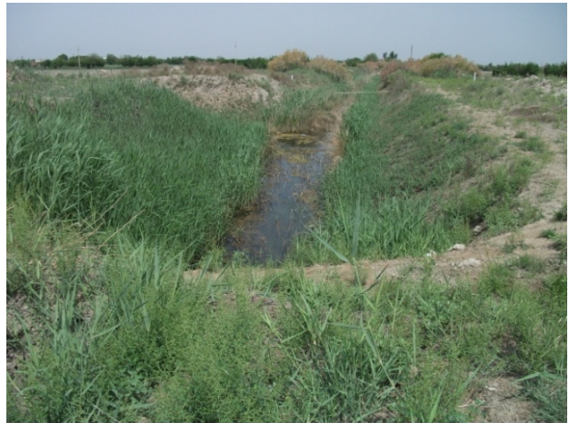
Drainage channel (km 229)
