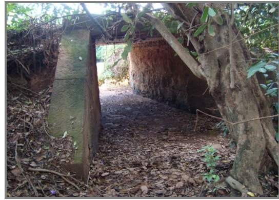
Bueiro utilizado como passagem de fauna adequada observada no riacho do Onça
