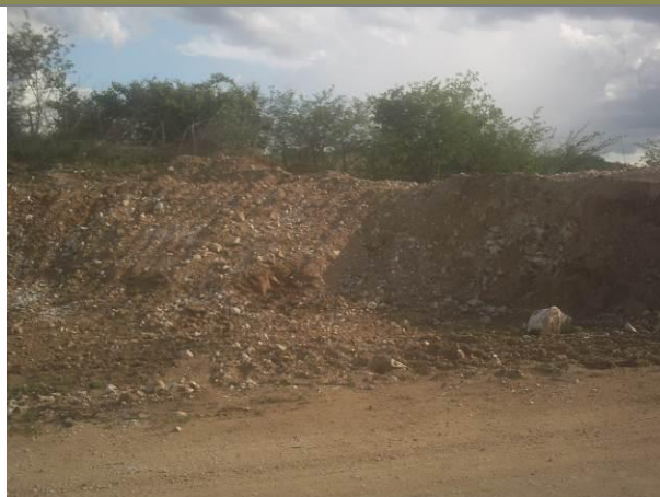
Área de empréstimo nos dois lados do trecho (E=341532 N=9568486)
