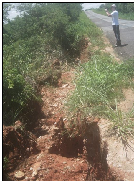
Erosão com solapamento do talude de aterro CE-060 Mombaça - Acopiara
