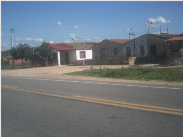
Casas próximas ao trecho - em Pirraceiro CE-060 Mombaça - Acopiara (Alargamento Plataforma)
