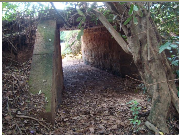
Bueiro com função de passagem de fauna adequada observada (E=345677 N=9612080)
