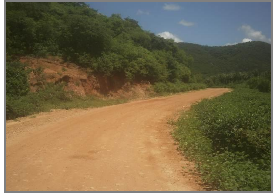
Escorregamento no talude do LE
