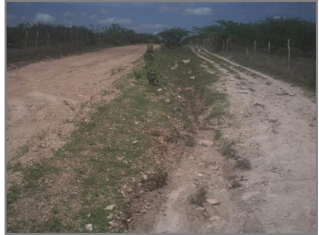
Ocorrência de solos mais propensos à erosão Sulcos erosivos instalados
