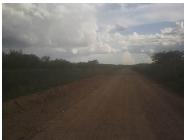
Trecho em relevo plano, próximo a Cariré (E=337846 N=9565466)
