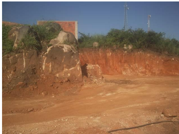
Área de empréstimo próximo a Caririaçu – presença da matacões (E=469091 N=9221024)
