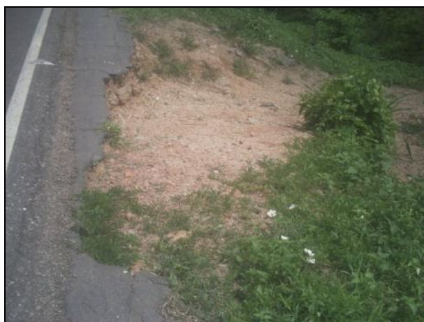
Sulcos erosivos as margens da rodovia CE-060 Mombaça - Acopiara (Alargamento Plataforma)
