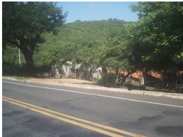
Ocupação próxima a faixa de domínio (E=466120 N=9218935)
