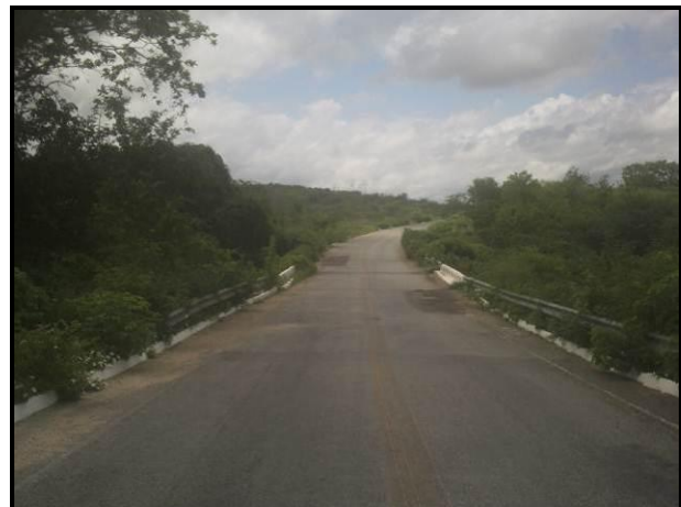
Ponte sobre Riacho Cajazeiras - relevo ondulado com curvas
