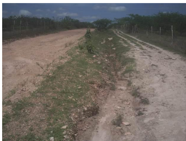
Ocorrência de solos mais propensos à erosão – Sulcos erosivos instalados (E=622565 N=9476134)
