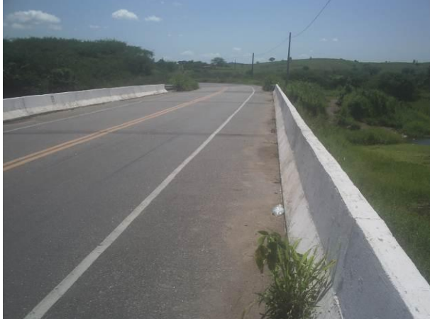
Ponte sobre Riacho dos Carás (E=466347 N=9211106)
