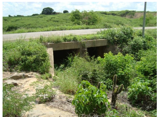
Modelo de passagem de fauna adequada observada (E=448037 N=9328580)
