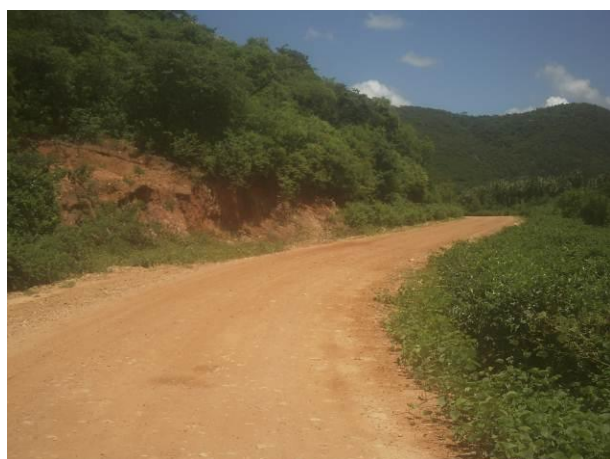
Escorregamento no talude (E=337471 N=9615773)
