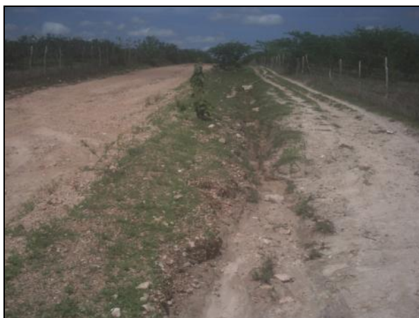
Sulcos erosivos as margens do trecho CE-371 Palhano - Entr. CE-123 (Itaiçaba)
