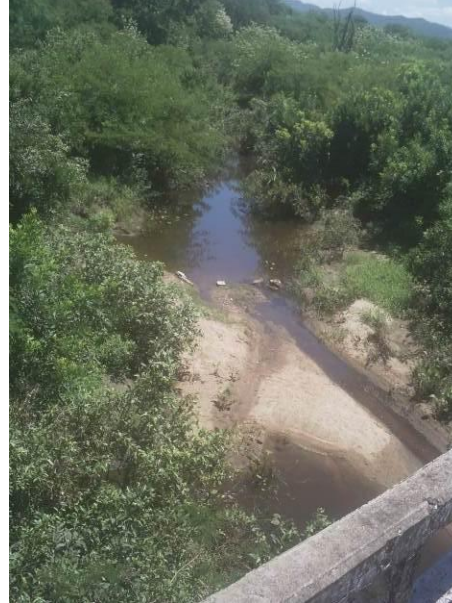
Ponte rio Ramalhete (E=432488 N=9319301)
