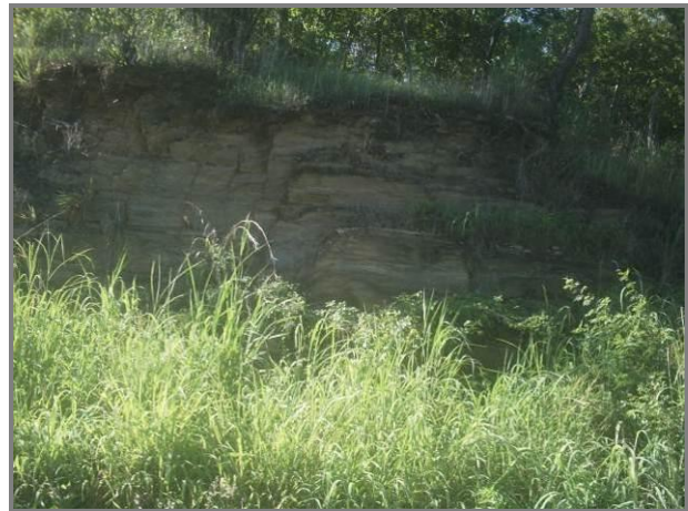
Talude de corte em rocha no LE
