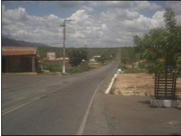
Jaibaras nas proximidades do trecho CE-183 Entr. BR 222 - Entr. CE 366 (Varjota)
