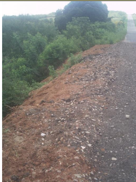
Erosão no LD – solapamento do talude de aterro (E=408421 N=9321629)
