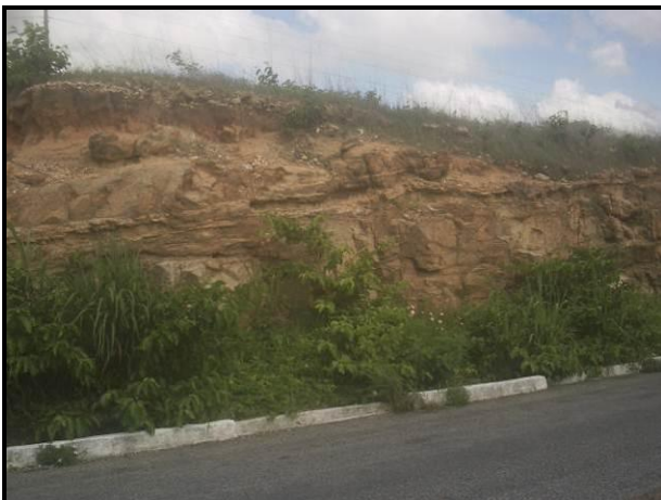
Talude de corte em rocha
