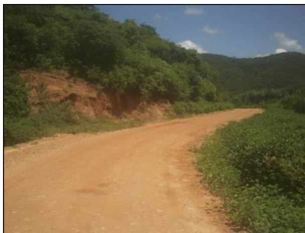
Talude de corte CE-232 Entr. CE 362 (Massapê) - Entr. CE-364 (Moraújo)
