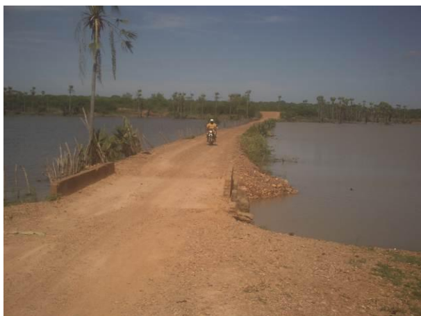
Rodovia é o corpo da barragem do Açude Gilvan José Barbosa (E=627321 N=9478529)
