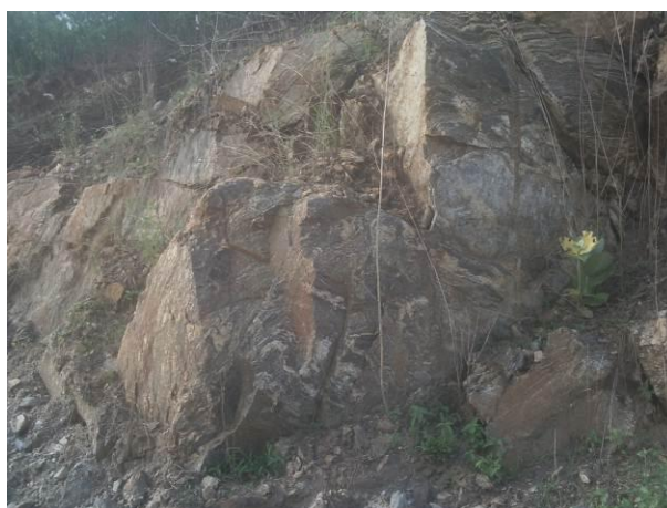
Taludes de corte em rocha intemperizada (E=339651 N=9568895)
