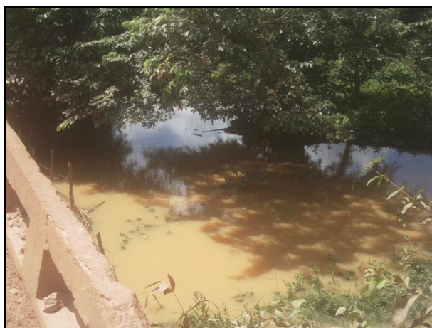
Ponte sobre riacho Raiz CE-232 Entr. CE -362 (Massapê) - Entr. CE-364 (Moraújo)
