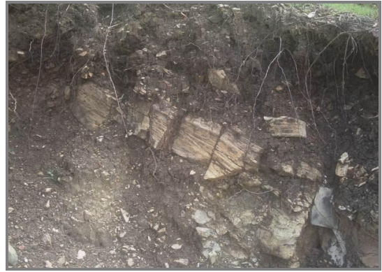
Talude de corte em rocha intemperizada e desconfinada
