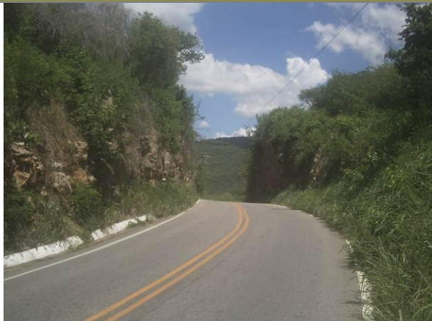
Taludes em rocha que também serão atingidos pelo alargamento da rodovia (E=438892 N=9349440)
