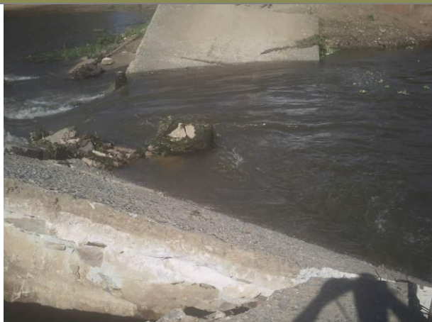
Ponte molhada sobre rio Acaraú danificada (E=343990 N=9568389)
