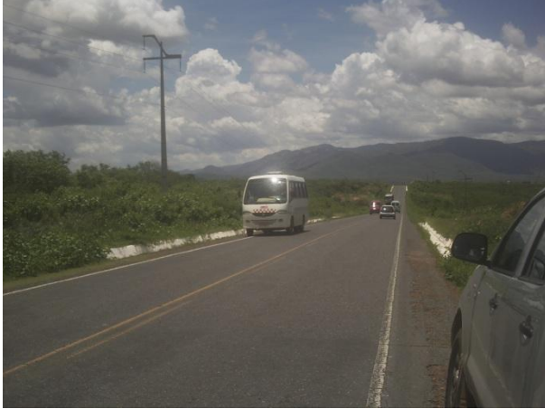
Tráfego de veículos no trecho (E=333726 N=9578486)
