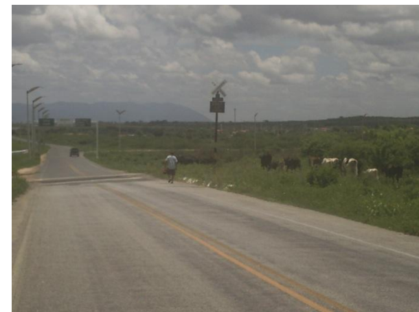
Passagem sobre linha férrea em Cariré (E=335271 N=9562015)
