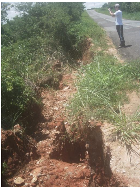
Erosão no LD – solapamento do talude de aterro (E=429139 N=9320872)
