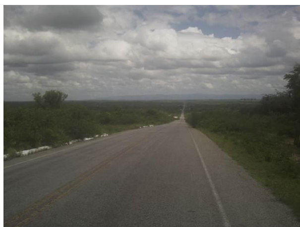
Vista da rodovia - Trecho em relevo plano (E=336593 N=9549531)
