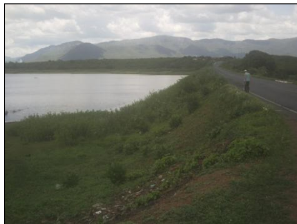
Açude Aires de Souza às margens da rodovia CE-183 Entr. BR-222 - Entr. CE-366 (Varjota)
