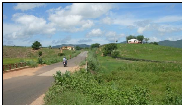
Início do trecho, rio interceptado pela estrada, este se apresenta assoreado e desprovido de vegetação ciliar
