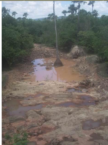
Drenagem interceptada pela estrada (E=318042 N=9614149)
