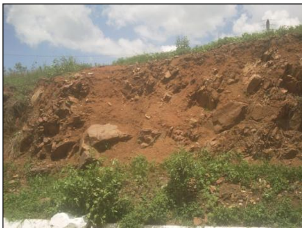
Talude com sinais de escorregamento CE-183 Entr. BR-222 - Entr. CE-366 (Varjota)
