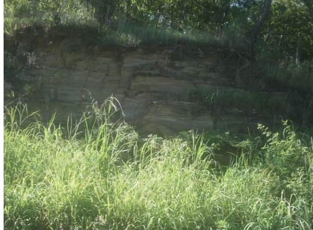
Talude de corte em rocha no LE (E=467493 N=9219229)
