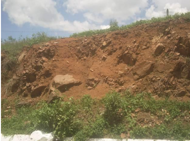
Talude de corte com rochas desconfiadas, risco de escorregamento e queda de blocos (E=333349 N=9580296)
