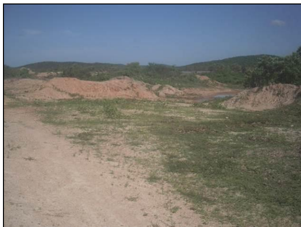
Área de empréstimo no LD – fonte de cascalho CE-371 Palhano - Entr. CE-123 (Itaiçaba)
