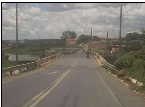
Vista da ponte sobre o vertedouro do Açude Aires de Souza
