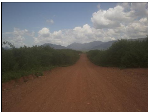
Vista da paisagem atual CE-232 Entr. CE-362 (Massapê) - Entr. CE-364 (Moraújo)
