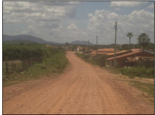
Casas próximas ao trecho - em Moraújo CE-232 Entr. CE-362 (Massapê) - Entr. CE-364 (Moraújo)
