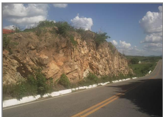
Talude em rocha a ser atingido pelo alargamento
