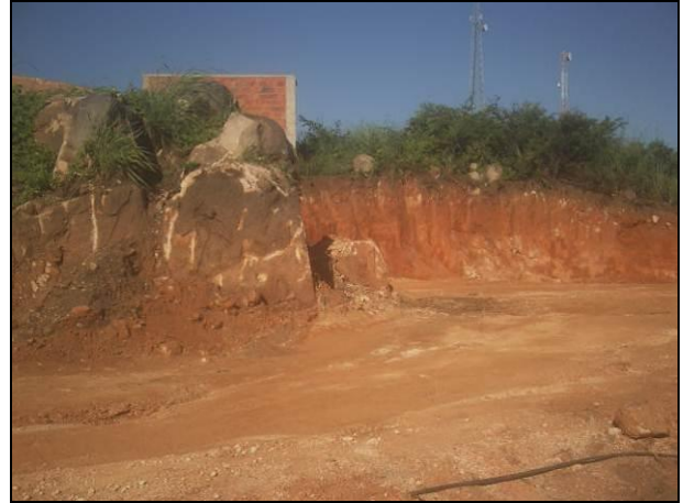
Área de empréstimo próximo a Caririáçu CE-060 Juazeiro do Norte - Caririáçu
