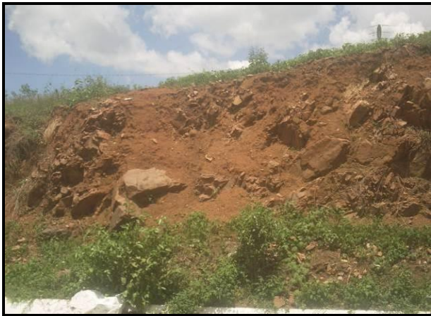
Talude de corte com rochas desconfiadas, risco de escorregamento e queda de blocos
