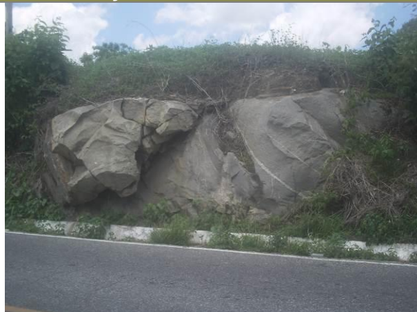
Risco de queda de blocos (E=442699 N=9340120)
