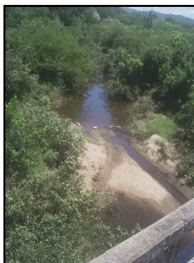
Ponte rio Ramalhete
