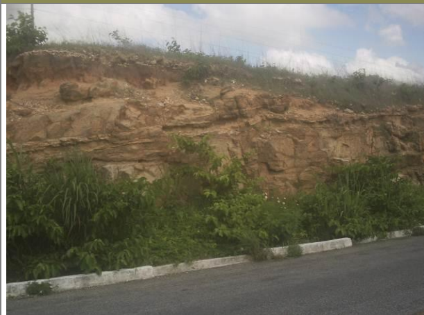
Talude de corte em rocha (E=337263 N=9538238)
