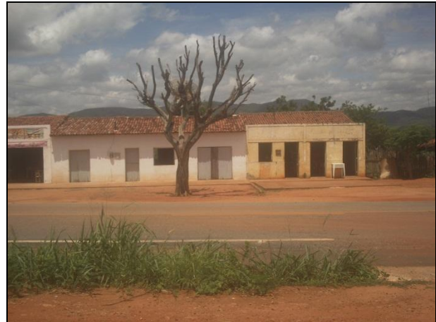
Localidade 'Mangueiras' CE-060 Mombaça - Acopiara (Alargamento Plataforma)
