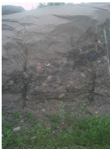
Talude de corte em rocha, com afloramento de Tiltos (E=333633 N=9578922)
