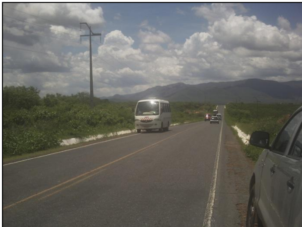
Tráfego local e transporte coletivo na rodovia
