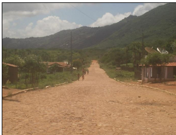
Passagem urbana de Pau Branco
