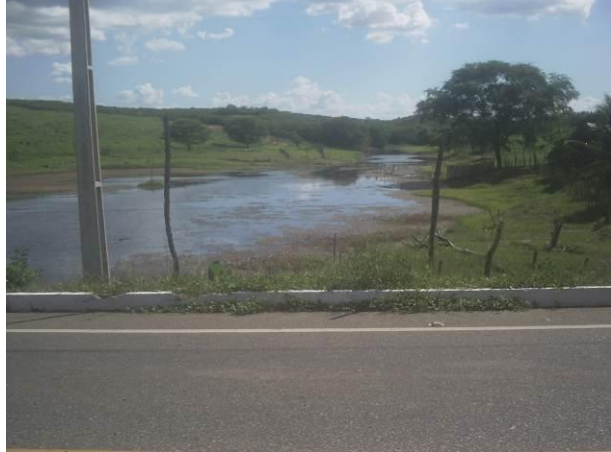
Área de curso d'água interceptado pela rodovia (E=430660 N=9362272)
