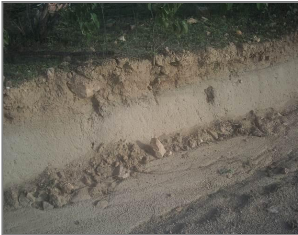
Presença de solo arenoso – material aluvionar
