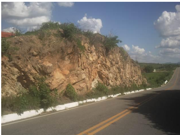
Talude em rocha a ser atingido pelo alargamento (E=431076 N=9361534)
