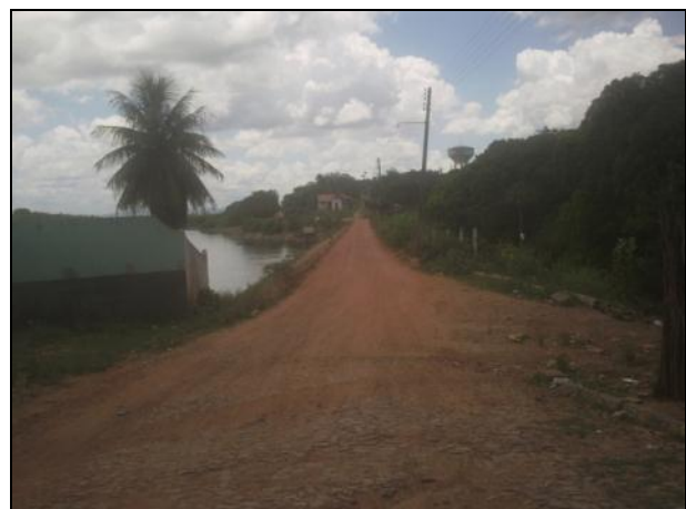
CE-232 Entr. CE-362 (Massapê) - Entr. CE-364 (Moraújo). A rodovia funciona como barragem do açude.
