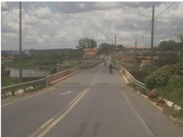
Vista da ponte sobre o vertedouro do Açude Aires de Souza (E=333862 N=9581922)
