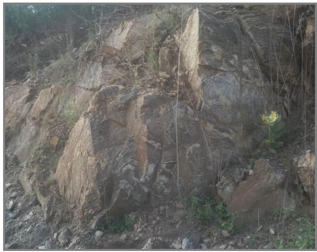
Taludes de corte em rocha intemperizada
