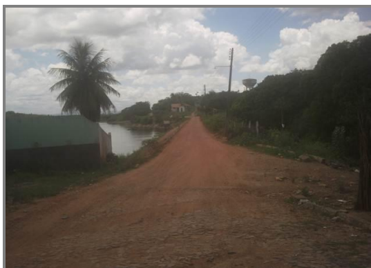
Aterro da estrada faz corpo da barragem do Açude Várzea da Volta
