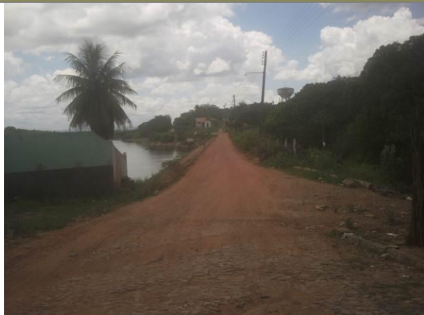
Aterro da estrada faz corpo da barragem do Açude Várzea da Volta (E=321597 N=9613071)
