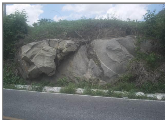
Risco de queda de blocos
