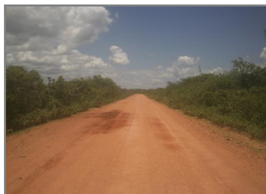
Vista do Trecho
