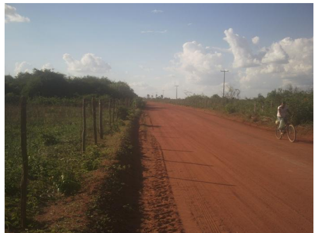
Vista do trecho com plantação na faixa de domínio (E=343115 N=9190092)
