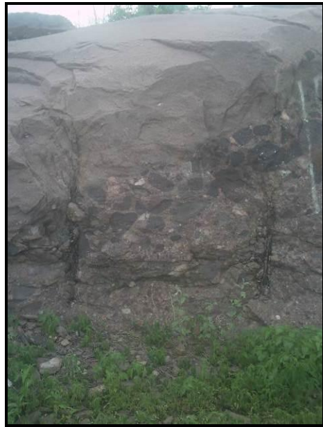
Talude de corte em rocha, com afloramento de Tilitos
