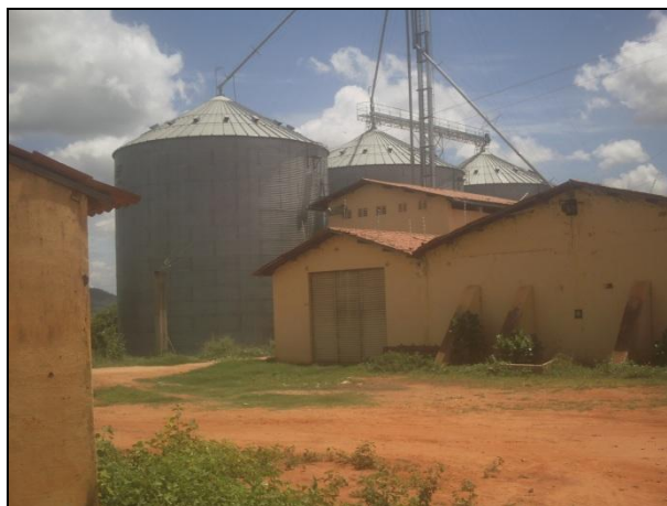
Fábrica de ração CASP na localidade de Mangueiras
