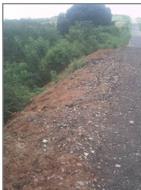
Erosão no LD – solapamento do talude de aterro
