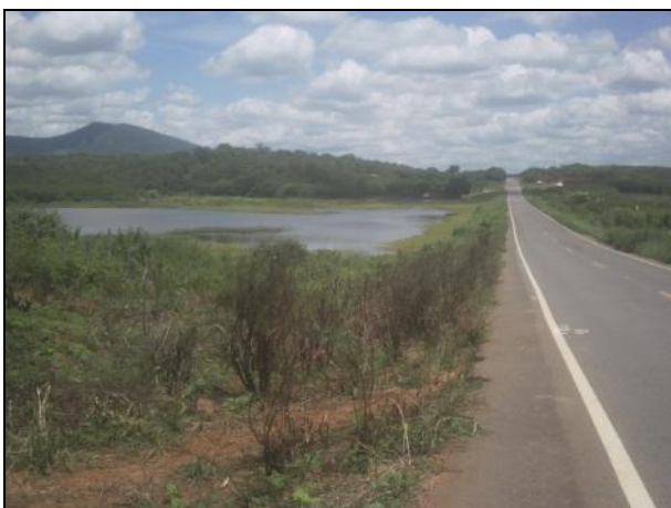
Açude às margens da rodovia. CE-060 Mombaça - Acopiara (Alargamento Plataforma)
