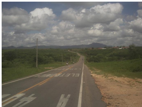
Vista do trecho com tráfego de motocicletas (E=448208 N=9328443)
