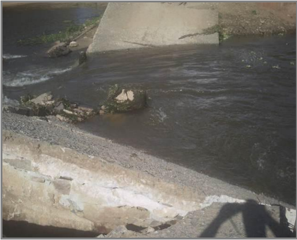
Ponte molhada sobre rio Acaraú danificada
