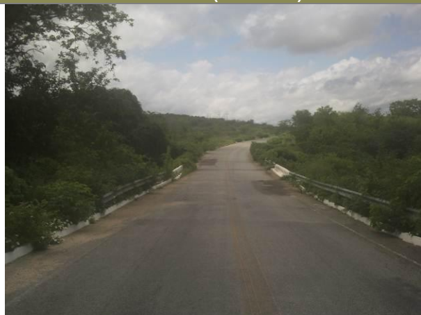
Ponte sobre Riacho Cajazeiras - relevo ondulado com curvas (E=337354 N=9541203)
