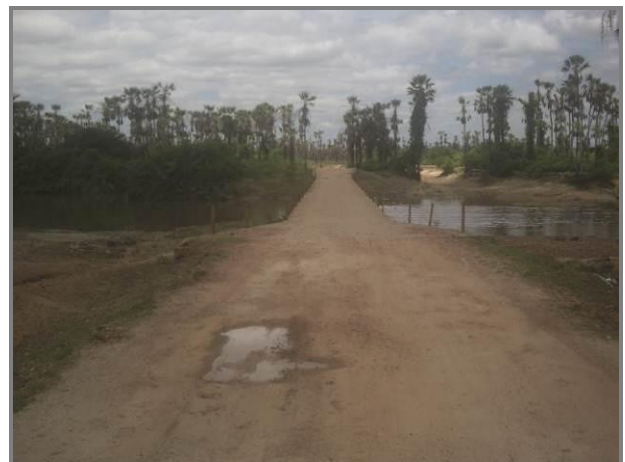
Ponte sobre rio Palhano
