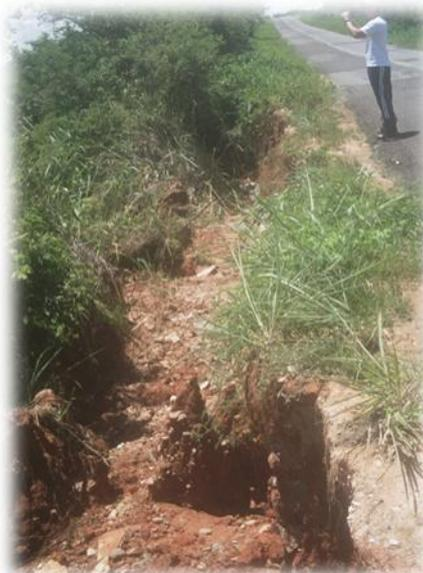
Erosão com solapamento do talude de aterro
