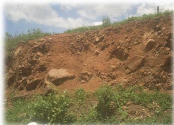
Talude com sinais de escorregamento
