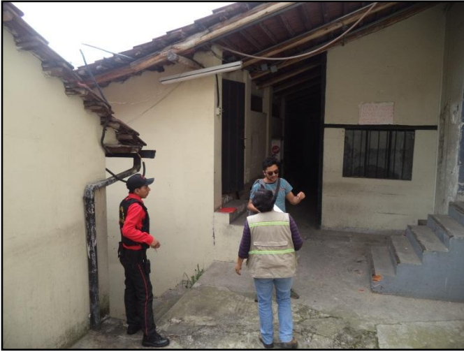
Visita al predio de la ex Cárcel Municipal 2 evidencia de fluorescentes
