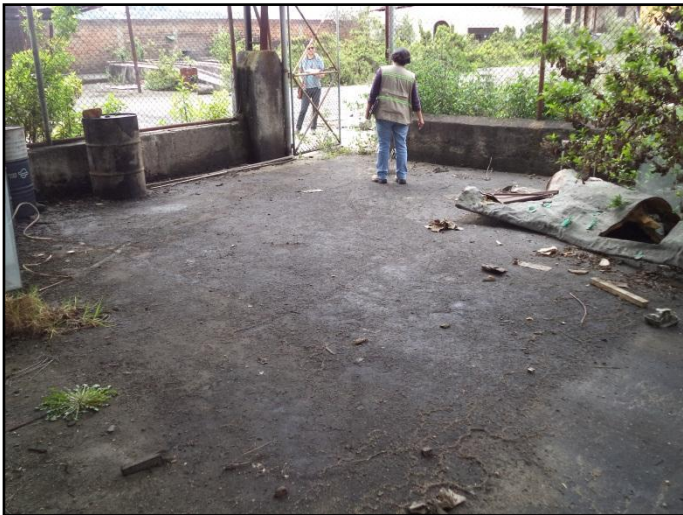
Evidencia de área con posibles derrames hidrocarburos
