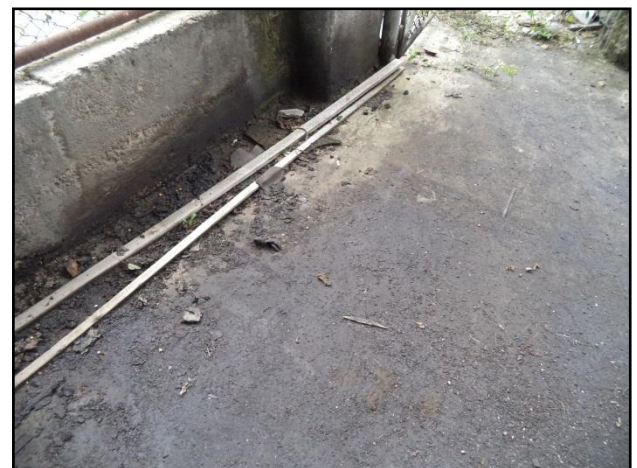
Evidencia de posibles derrames de hidrocarburos en el predio de la Mecánica
