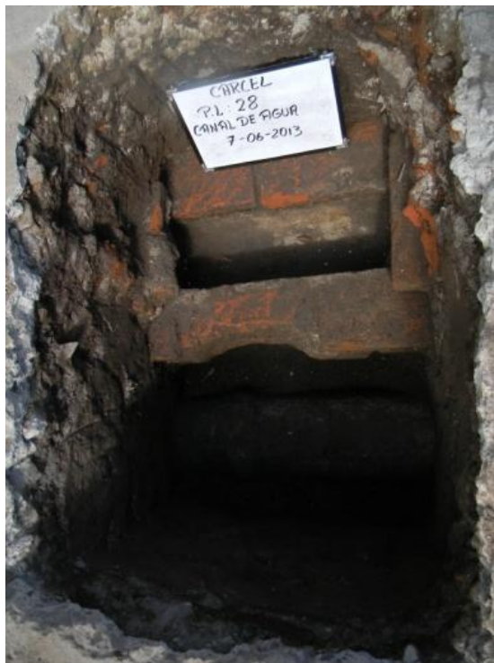
Foto 84: Canal de ladrillo en el patio de la cárcel.
