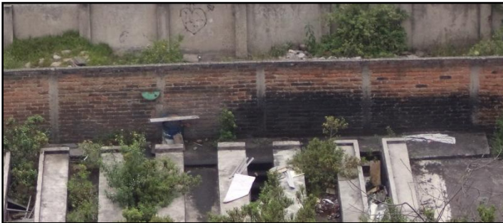
Evidencia de ladrillos con posibles derrames hidrocarburos
