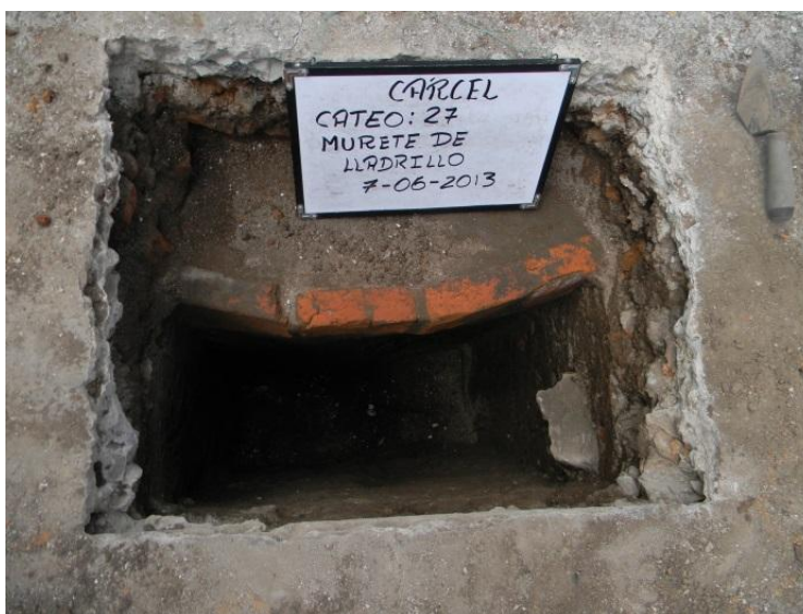
Foto 82: Muro de ladrillos de algún jardín central.
