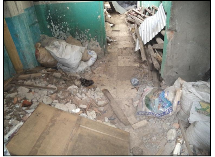
Evidencia de escombros en el predio ex Cárcel Municipal 2
