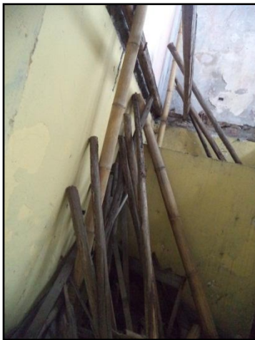
Evidencia de escombros en el predio ex Cárcel Municipal 2
