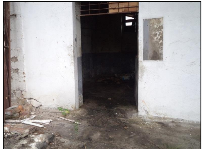
Evidencia de área con posibles derrames de hidrocarburos
