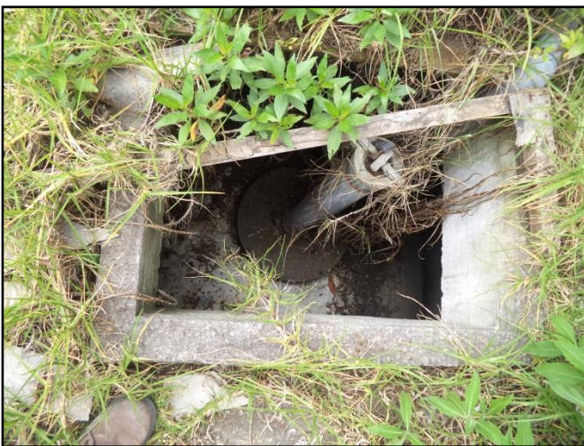
Tanque metálico de almacenamiento de combustibles en el predio de la Mecánica Municipal
