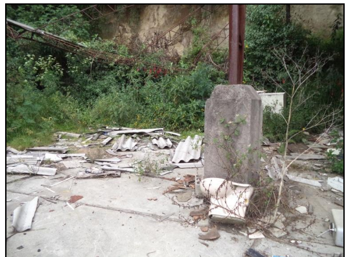
Evidencia de escombros en el predio de la Mecánica Municipal
