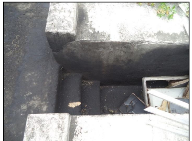
Fosas con posibles derrames de hidrocarburos
