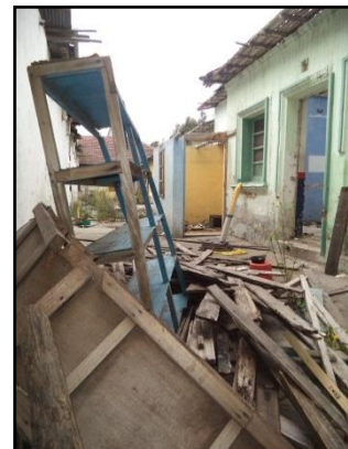
Evidencia de escombros en predio Baños Públicos Municipal
