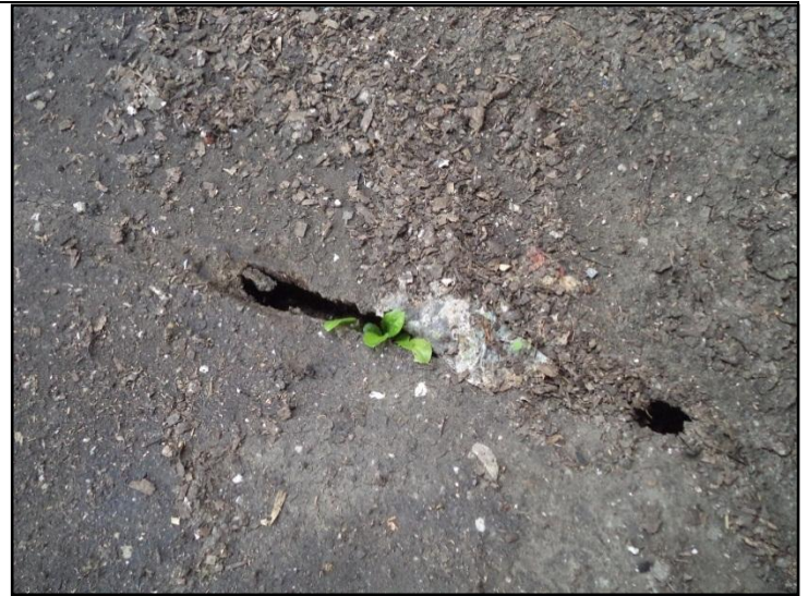
Evidencia de huecos en juntas de concreto
