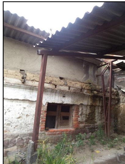
Estructuras metálicas temporales
