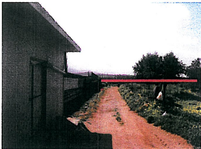
Φ34: ΠΕΡΙΟΧΗ ΔΙΕΛΕΥΣΗΣ ΤΗΣ ΟΔΟΥ ΑΠΟ ΤΗ Χ.Θ. 16+750 ΕΩΣ Χ.Θ. 16+850
