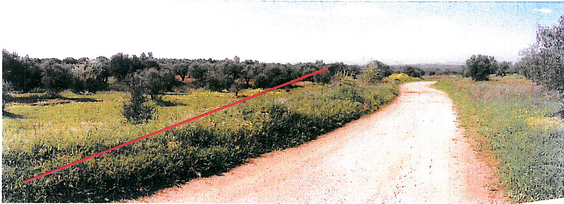
Φ36: ΠΕΡΙΟΧΗ ΔΙΕΛΕΥΣΗΣ ΤΗΣ ΟΔΟΥ ΑΕΡΟΔΡΟΜΙΟ – ΑΡΚΑΛΟΧΩΡΙ ΑΠΟ ΤΗ Χ.Θ. 1+150 ΕΩΣ Χ.Θ. 1+300
