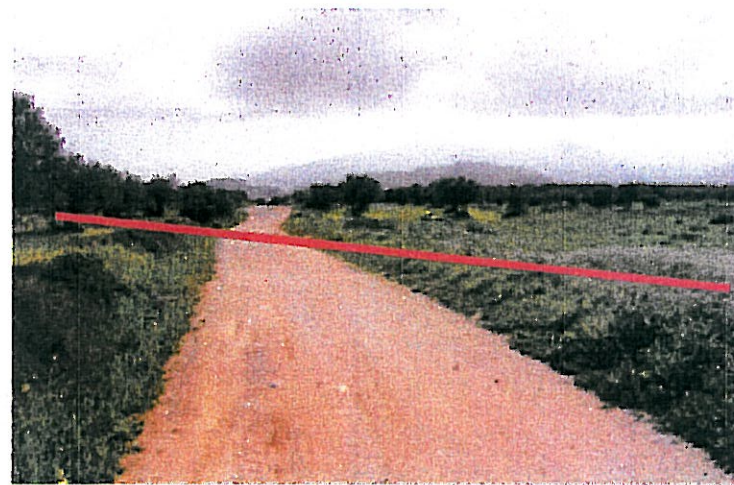
Φ35: ΠΕΡΙΟΧΗ ΔΙΕΛΕΥΣΗΣ ΟΔΟΥ ΑΕΡΟΔΡΟΜΙΟ – ΑΡΚΑΛΟΧΩΡΙ ΑΠΟ ΤΗ Χ.Θ. 0+400 ΕΩΣ Χ.Θ. 0+450
