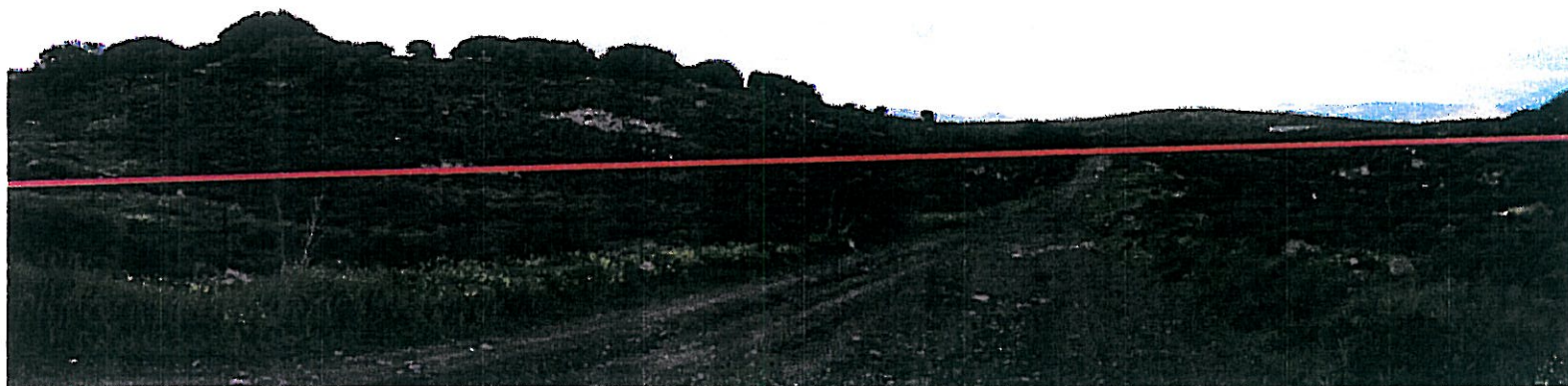
Φ48: ΠΕΡΙΟΧΗ ΔΙΕΛΥΣΗΣ ΤΗΣ ΕΝΑΛΛΑΚΤΙΚΗΣ ΛΥΣΗΣ ΑΠΟ ΤΗ Χ.Θ. 3+300 ΕΩΣ ΤΗΣ Χ.Θ. 3+800 ΠΕΡΙΠΟΥ
