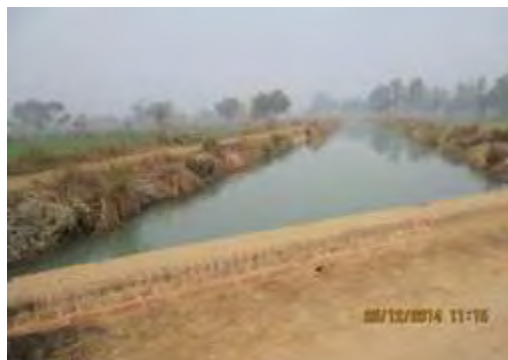
Fig. 41:Canal at km 2.650in Pilakna
