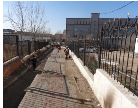
Зураг 2: Дахин барих бетон суурьтай төмөр хашаа
