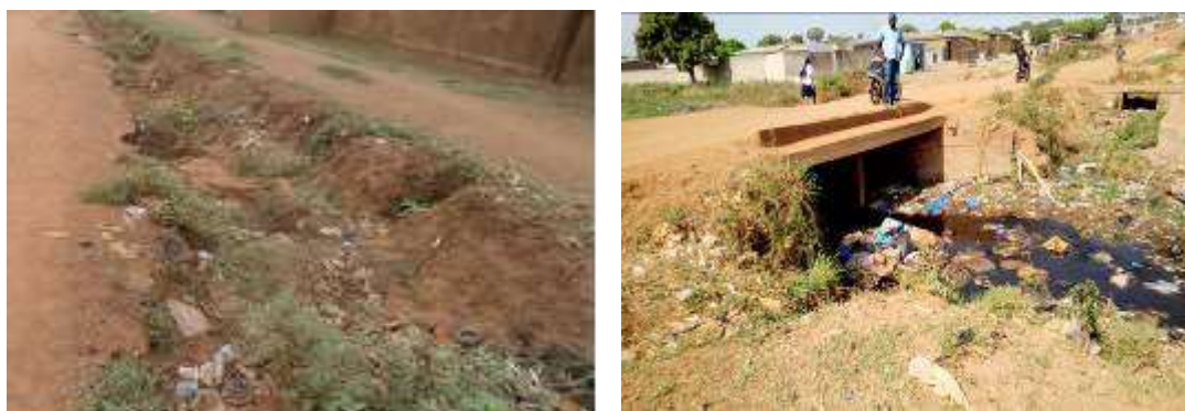
Photo 5 : Aperçu de ravin créé par le ruissellement des eaux et de l'unique dalot de la route
