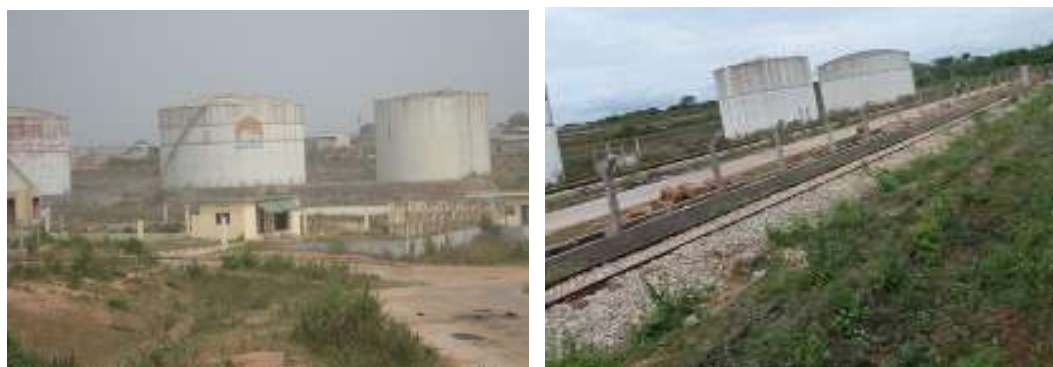
Photo 10 : Aperçu des installations de la GESTOCI Bouaké
