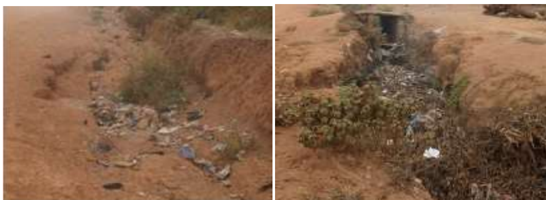
Photo 13 : Aperçu de ravins créés par l'érosion
