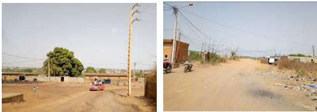
Photo 6 : Aperçu d'installations électriques et de raccordements anarchiques au réseau d'électricité
