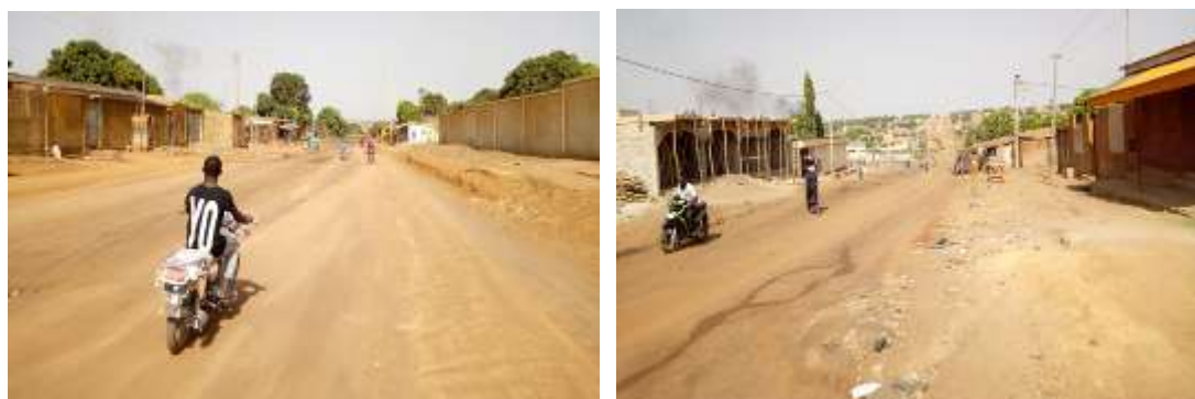
Photo 3 : Aperçu de l'emprise de la route à la traversée des quartiers Dar es Salam et Tollakoudiokro
