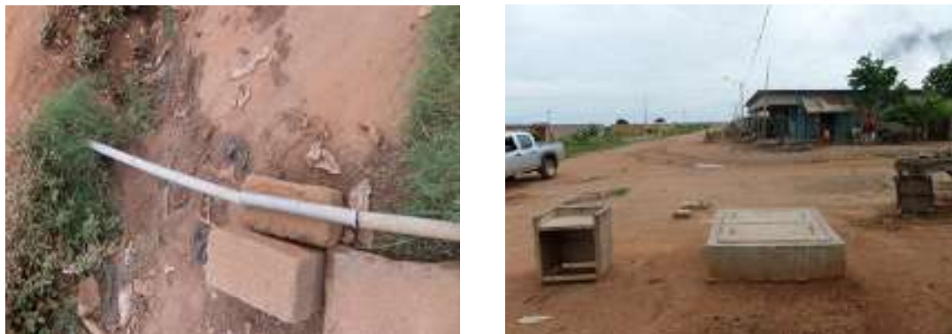
Photo 7 : Aperçu d'installations d'alimentation en eau potable dans l'emprise de la route
