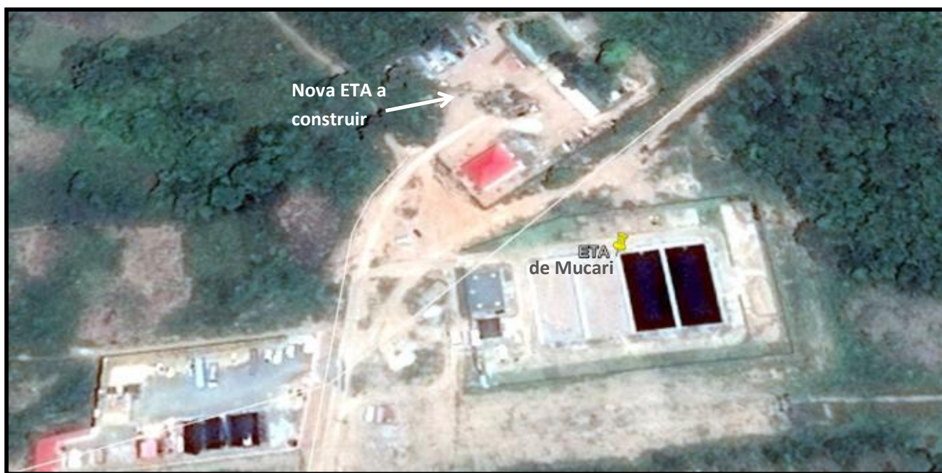
Ilustração 7 - Local de ampliação da ETA (terreno reservado para o efeito).
