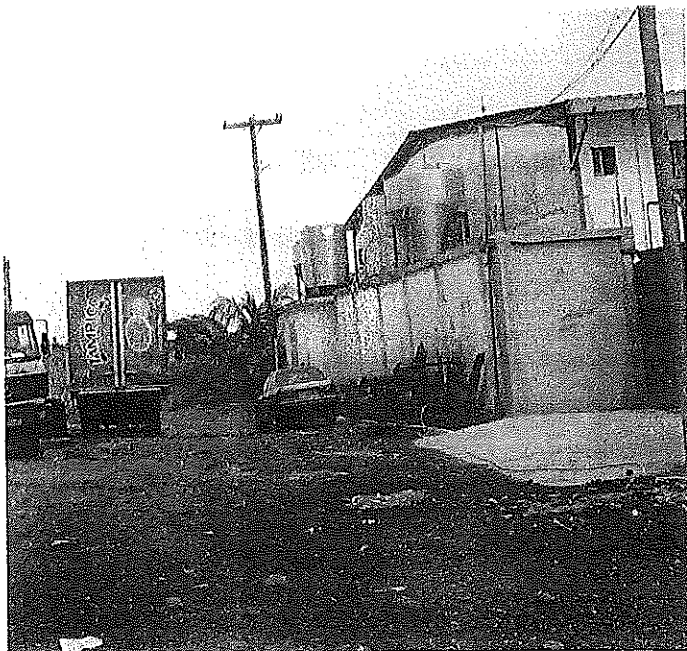
Photo 1 : vue latérale du site et de l'usine
