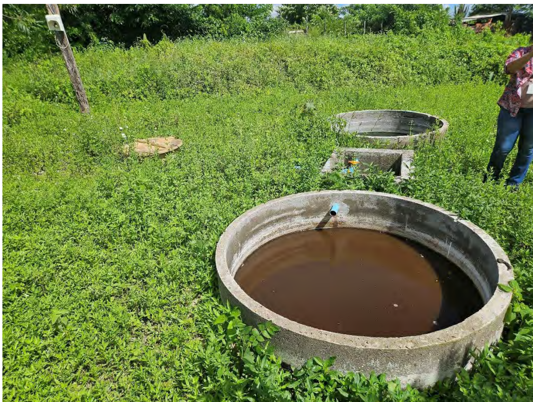
Foto 50 – Sistema de reuso de águas cinzas no assentamento São Domingos, no Município de Cubati
