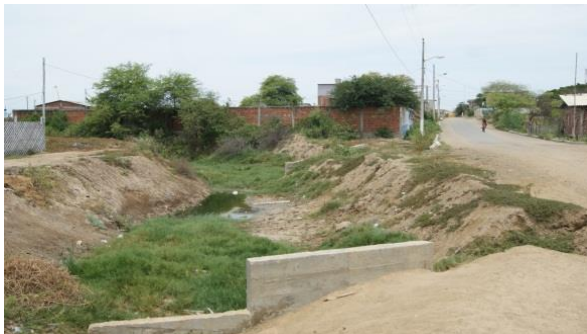
Ilustración 13 - Descarga de colectores a cuerpo hídrico
