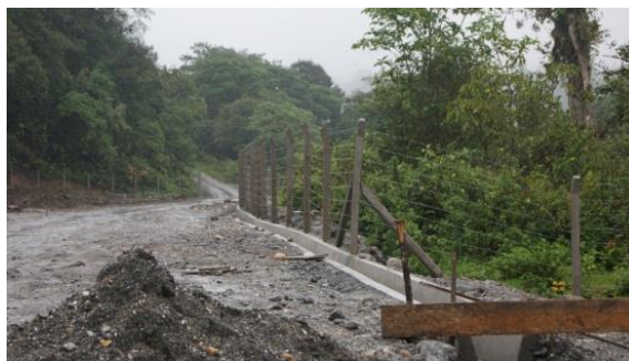
Ilustración 17- vía de acceso a el proyecto
