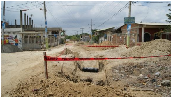
Ilustración 12 - Instalación de redes colectoras
