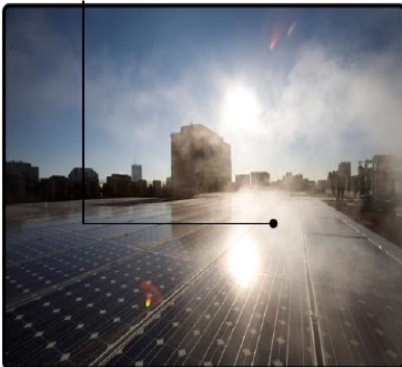
Նկար 6: ՖՎ վահանների վրա առաջացող տիպային շողանք
