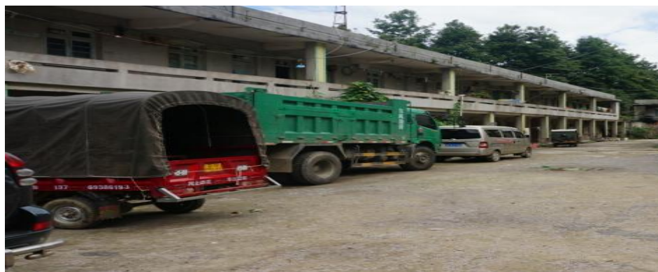
图8 新街镇公路管理所职工办公楼
