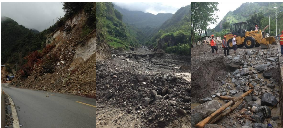
图 7 道路塌方及抢通
