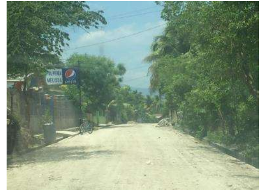
Condiciones actuales del acceso
