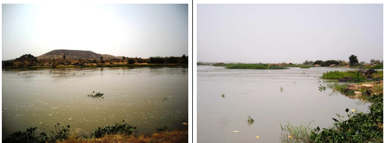
Photo 1: Vue de l'axe du futur barrage et vue du futur réservoir du barrage
