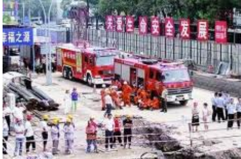
西安地铁1号线塌方事故现场
