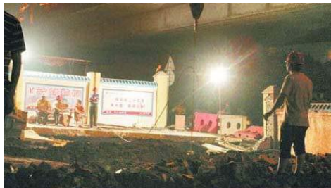
广州地铁5号线事故现场
