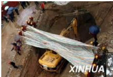
北京地铁10号线施工事故现场
