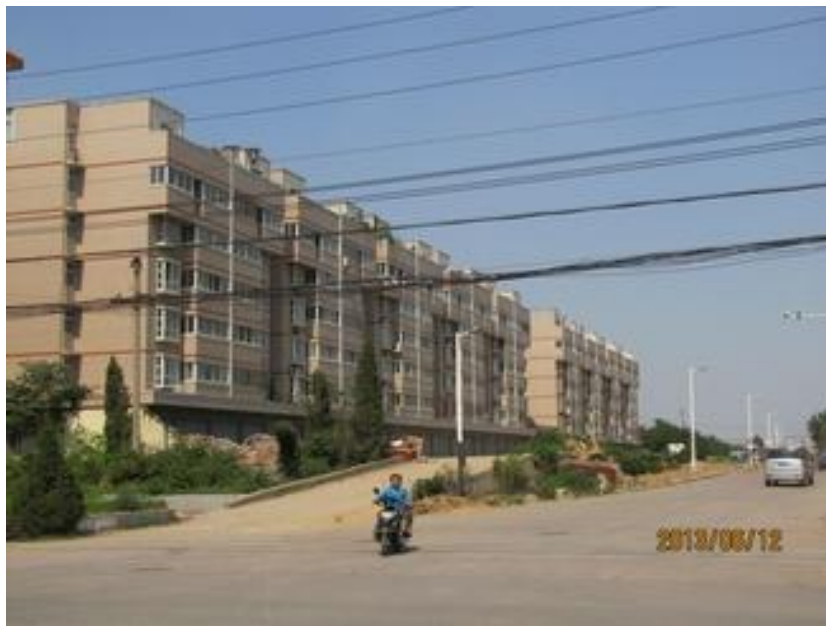
图 7.2-8 长兴路北延现状照片
