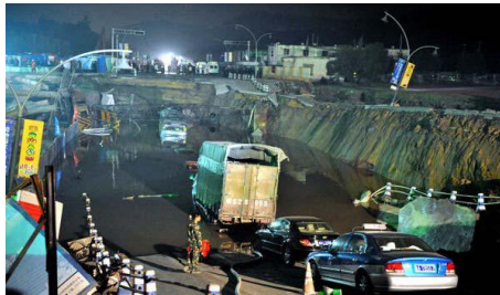
杭州地铁施工事故现场
