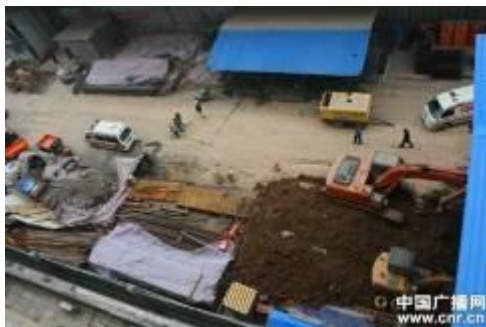
西安地铁3号线塌方事故现场
