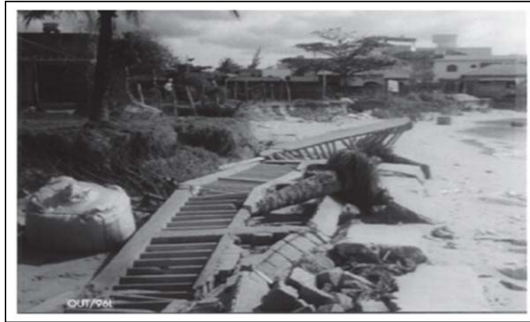
Figura 2: Erosão na Praia Grande após evento de tempestade. Foto: Luis Viana, 1996. Adaptado de SILVA et al, 2010.
